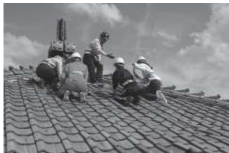
写真17 制作した瓦を使って屋根の葺替を行う
