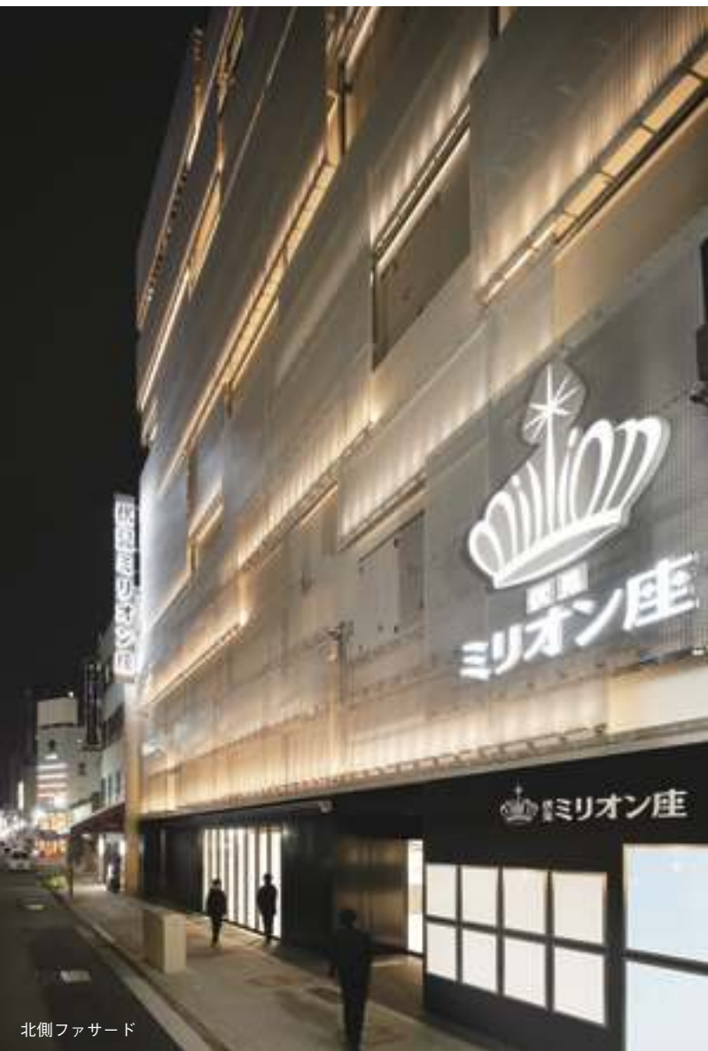
北側全景（夜景）
