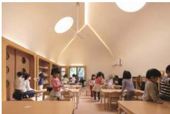
天井は稜線が開いていく寄棟形状とし、隙間に間接照明を設置し柔らかな空間を演出した*
