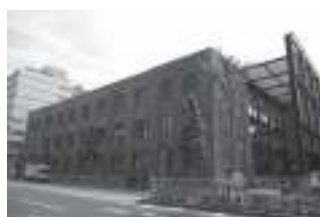
旧新風館 改修設計：R.ロジャース＋ NTTファシリティーズ 撮影：笠原一人
