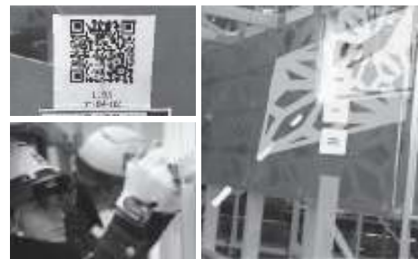
写真4 MRを活用した施工アシスト
