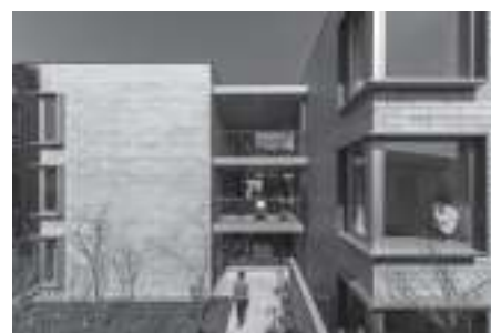
写真3 建物南側より撮影
