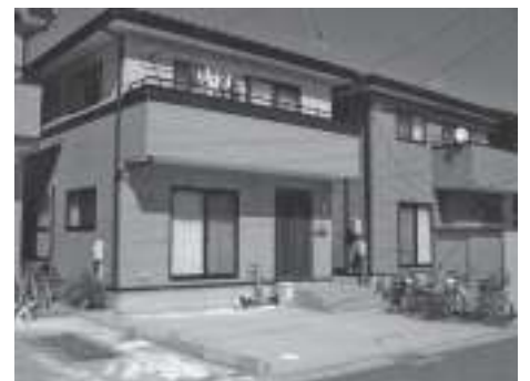
fig.5 むき出し住宅
