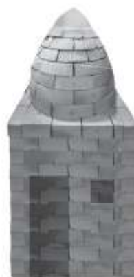
写真2 CO2エコストラクチャーの丸屋根住居の試作
