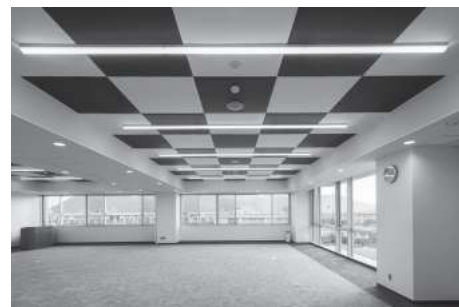
写真4 かるてん在来工法施工例
