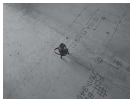
写真2 床面に描画された施工図の活用例
