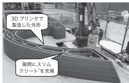
写真3 シェル型ベンチの製造状況
