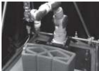
写真1 アーチ状ブリッジの製造状況
