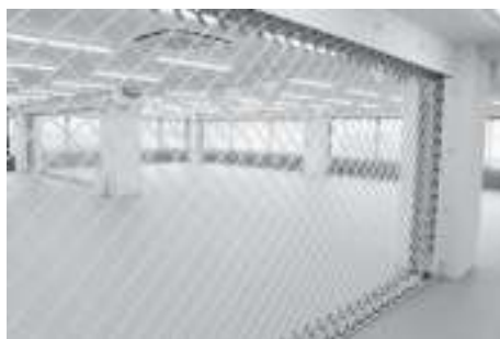
写真4 内部補強
