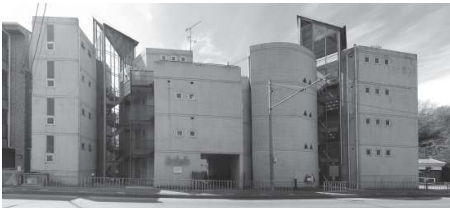
①氷室アパートメントを北（道路側）から見る。二本の目地のうち上は打継ぎ目地、下は化粧目地。三角形の窓はタイプBの玄関の足元を照らしている。
