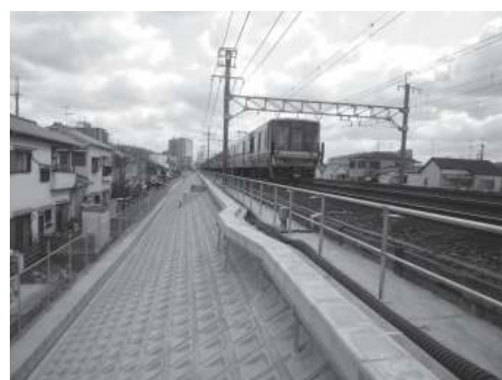
写真3 斜面防災対策例
