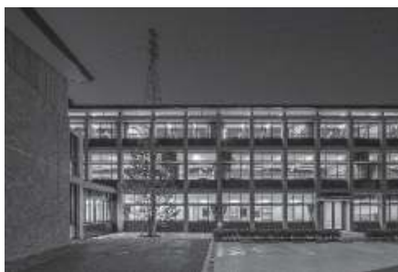
図2 外観写真：教室部
