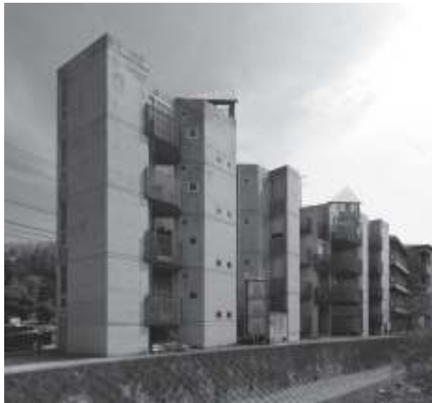
⑦南（川側）から見る。ベランダの手摺はパンチングメタル。
