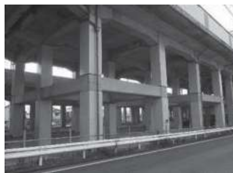
写真4 耐震補強例
