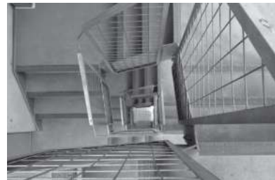
⑧階段見下ろし。吹抜けの真下のみタイルの色を変えている。
