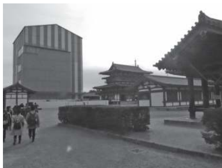
薬師寺東塔の解体修理現場
