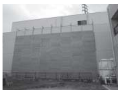
防音パネル取付後全景
