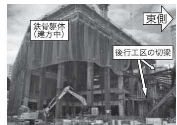
写真1 本設躯体と切梁
