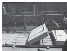
PCa材（吊込み、設置）
