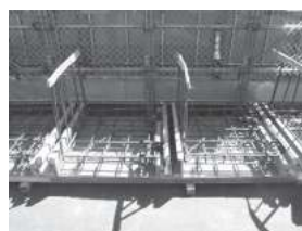
PCa材（コンクリート打設前）
