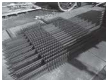
写真6 スラブ筋のユニット化
