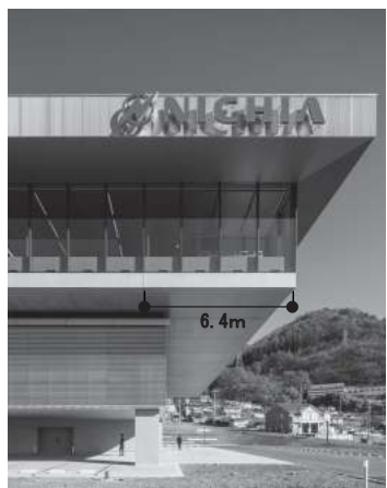
写真2 6.4m跳出し見上げ
