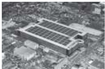
写真4 全体竣工写真
