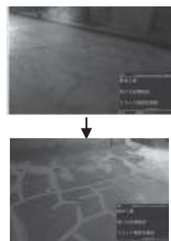
図2 除染水流出防止状況
