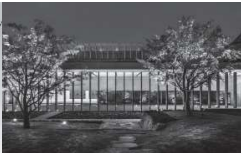
上部：ガラスダブルスキン、下部：エントランスの鉄骨無垢細柱
