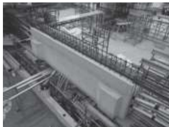
写真5 基礎大梁のPC化
