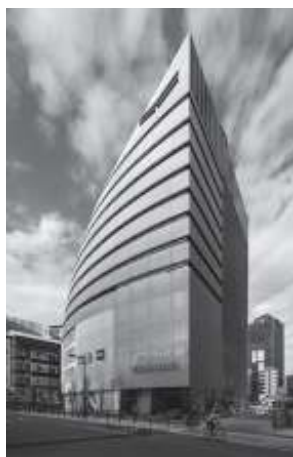
写真1 全体竣工写真
