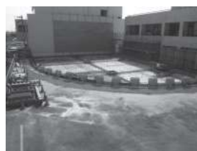
PCa材（設置後全景）
