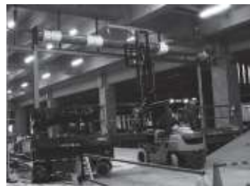
写真8 シャッターユニット現場付付
