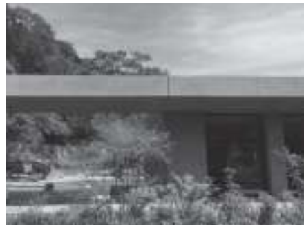
写真2 エキスパンションジョイント
