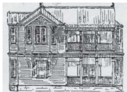
図5 旧ストロヴィー邸 上：解体中の様子、キングポストトラスが載る（撮影：坂本勝比古）、下：南立面（画：坂本勝比古）
