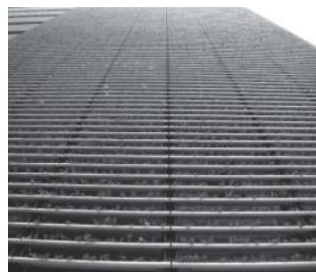
写真3 緑化ルーバー外観
