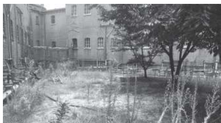
写真4(注) 第3寮と第4寮の間の空間
