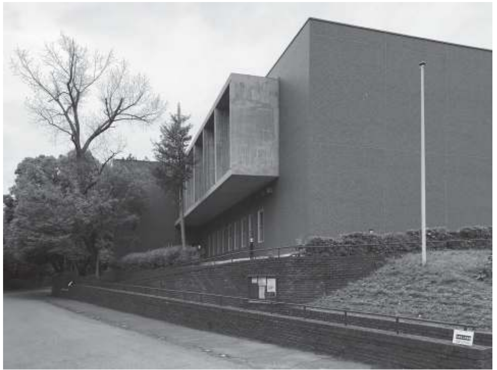
写真3 ほとんど建設当初の姿を残しながら改修されたファサード (写真2、3は筆者撮影)
