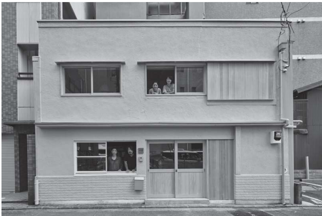
築70年以上の古い既存建物を、外観のイメージをあまり変えずにリノベーションした
