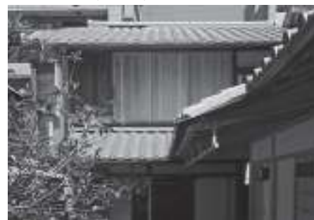
写真2 木製雨戸の設置事例
