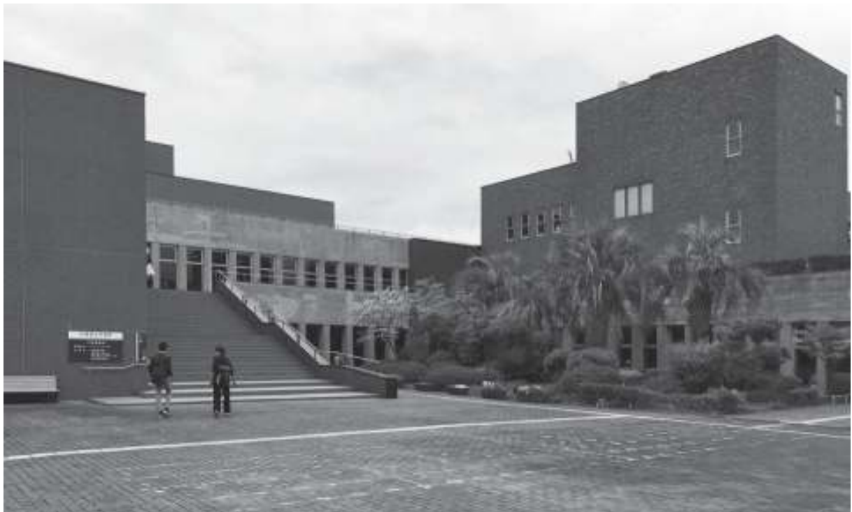
写真2 まとめきれなかった前庭の空間（左側が県立図書館、右側が明石市立図書館）
