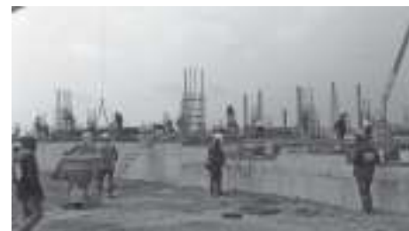
日系工場の工事現場の様子
