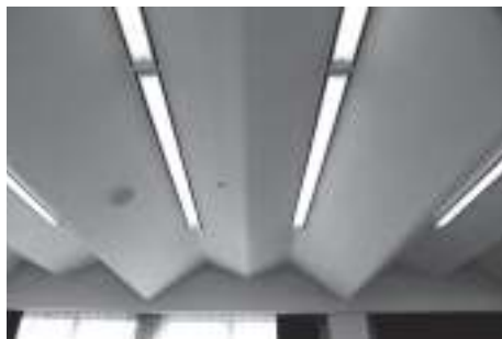
写真3 大会議室天井詳細
