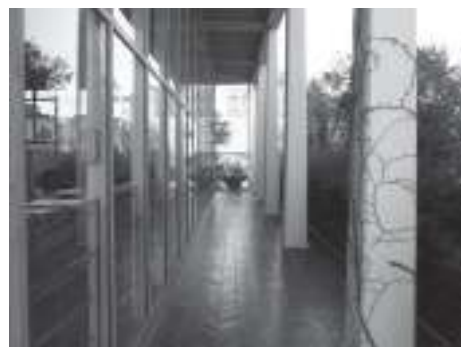
写真14 低層部のピロティ。村野がよく用いたヘリンボーンのタイル床
