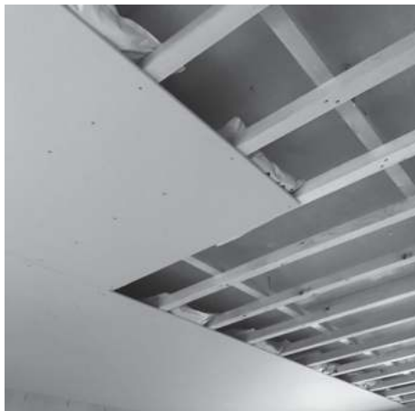
木製天井下地
