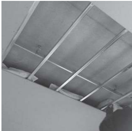
鋼製天井下地
