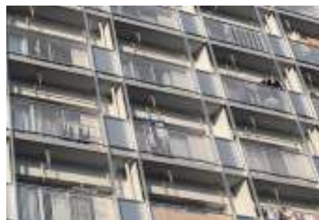
写真3 改修後外観写真
