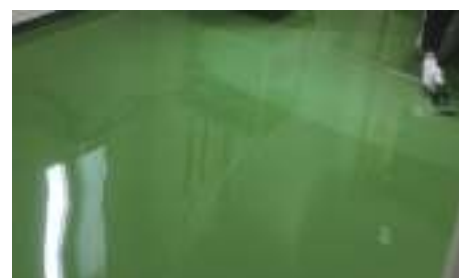
写真2 ピュールハードAH工法施工の様子
