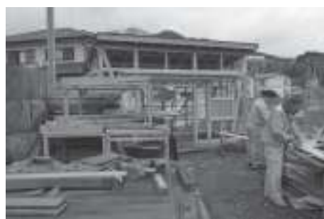
写真8 屋外のキッチンの建設
