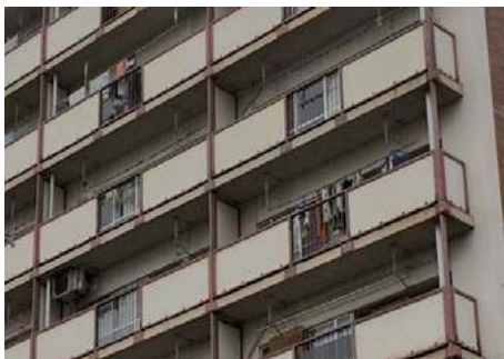
写真1 改修前外観写真
