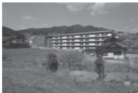
写真2 55戸の災害公営住宅「平南アパート」
