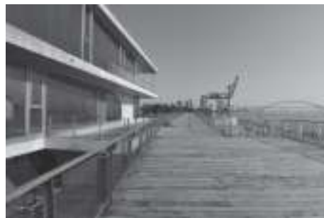
写真6 龍美術館(西岸館)
