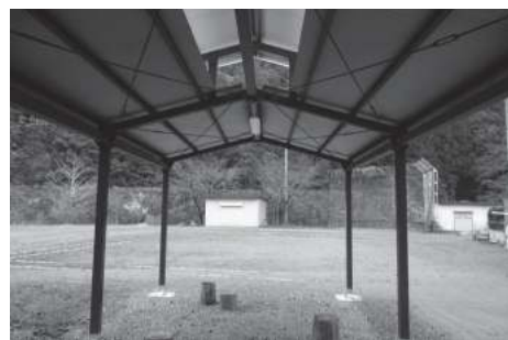
図7 グラウンドに設けられた野外作業場 (2018年11月)
