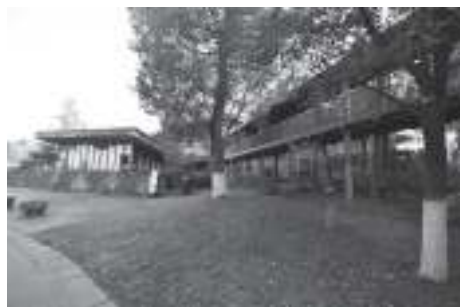
写真26 鉄骨のデッキ
