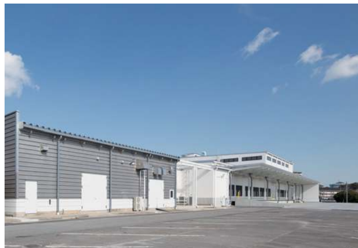
南西より 手前が既存建物
