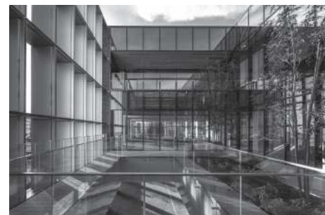
写真11 各階のオフィス空間に光と風を呼び込むテラス*
