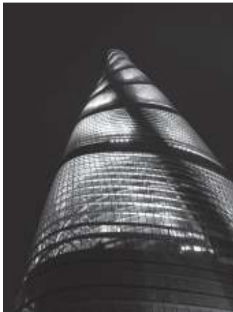
写真4 上海中心大厦
