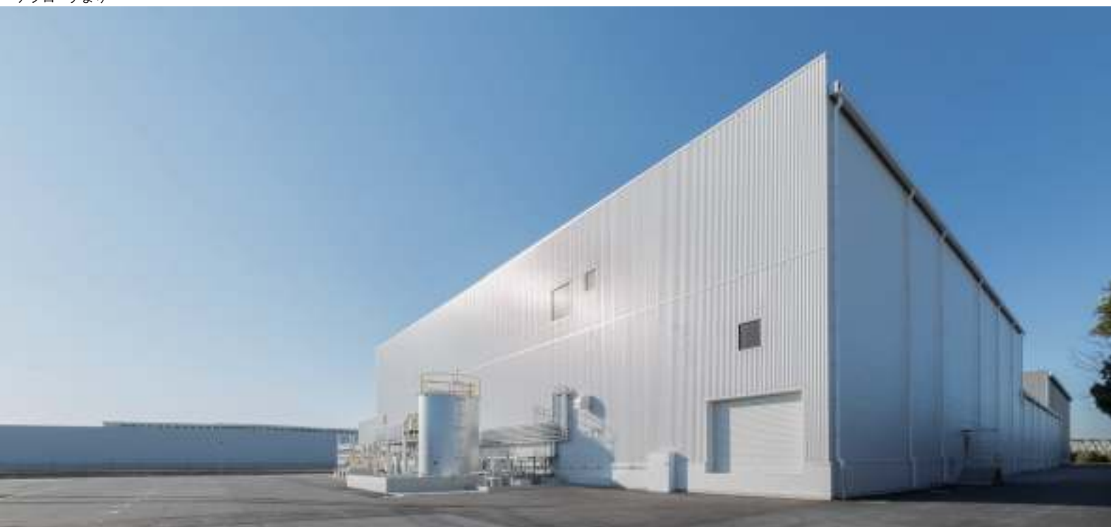
北東より 左奥が高浜第1工場
