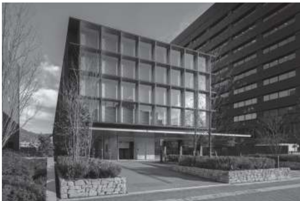
写真10 日射の自動制御も行う端正なファサード*
