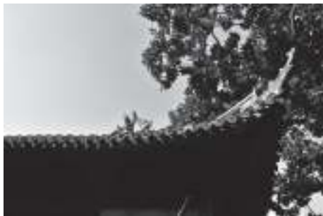
写真10 豫園 屋根の反り
