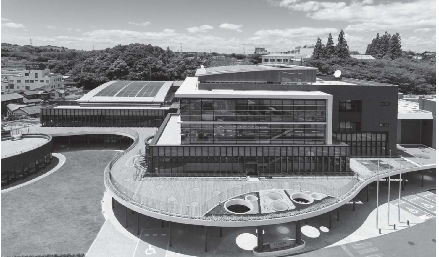
縁側モールの屋根「縁側テラス」：歩行空間として屋内外をつなぎ、地上との回遊動線を構成する
