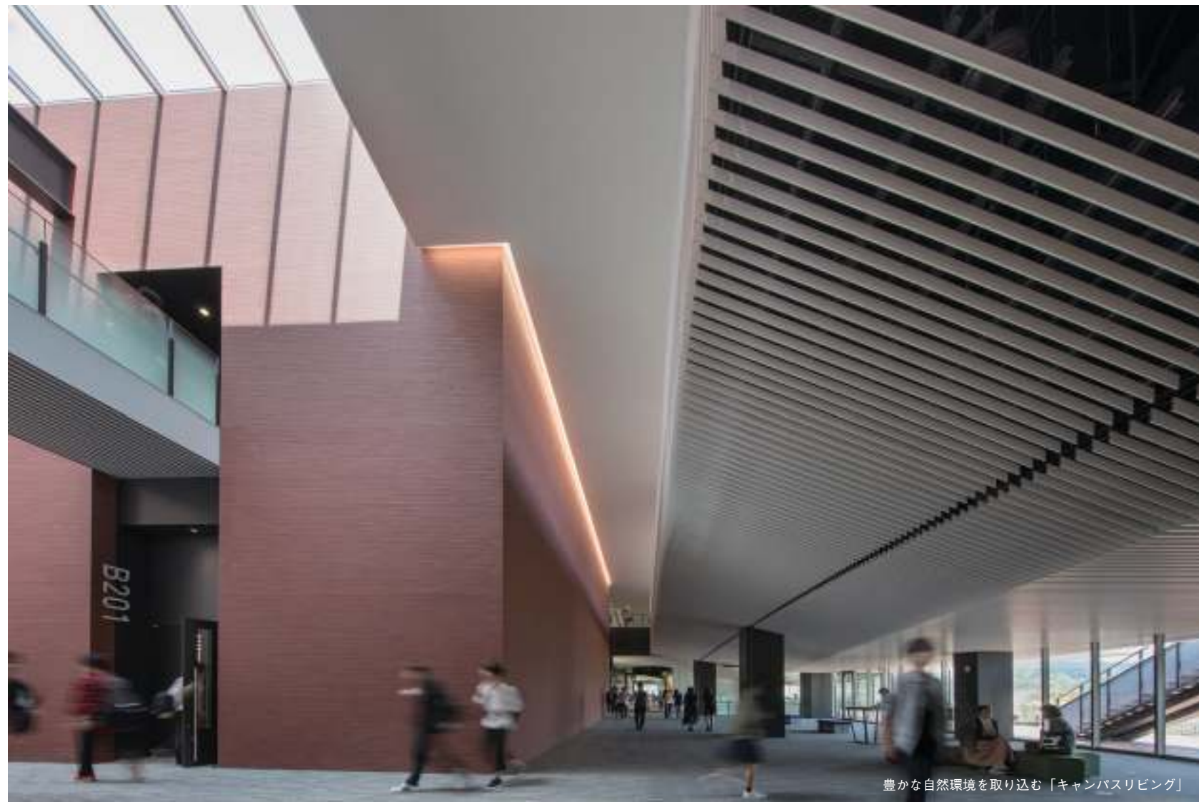
東面のオープンスペースに面した4棟構成の建物ボリューム 南側（写真左）にはゲート、北側（写真右）にはアリーナ外壁が位置する
