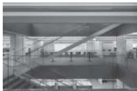
写真1 鉄骨階段の外観
