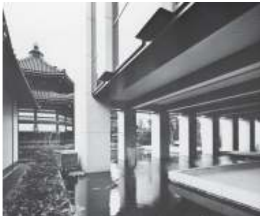
③敷地北東奥から1階ピロティ周りと六角堂を見る。 「建築と社会」1977年3月号
