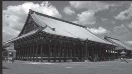
2004 西本願寺御影堂 修復工事及び境内
