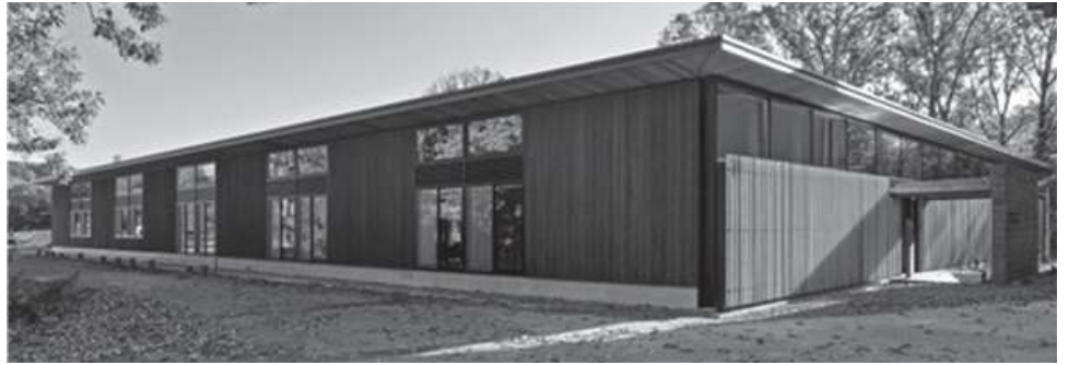
京都府農林水産技術センター 農林センター 茶業研究所（屋根にCLT部材使用）
