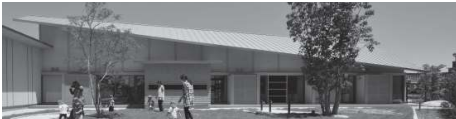
切妻屋根のヴォリュームを斜めにカットした単純な形態とし、大屋根の雨水は園庭の脇の雨受にガーゴイルで開放としている
