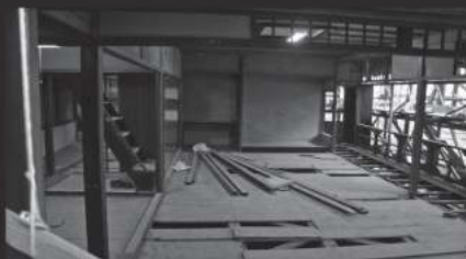
2014 旧三井家下鴨別邸 修復工事
