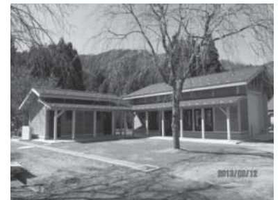
林業大学校 実習棟
