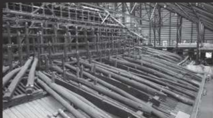
2014 知恩院御影堂 修復工事及び境内
