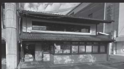
2000 セカンドハウス 東洞院（改修京町家）
