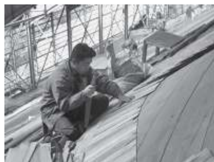
本願寺御影堂の土居葺き
