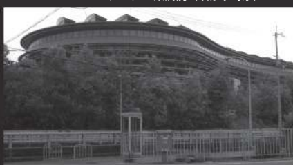
2001 京都市西京極総合運動公園屋内プール棟他
