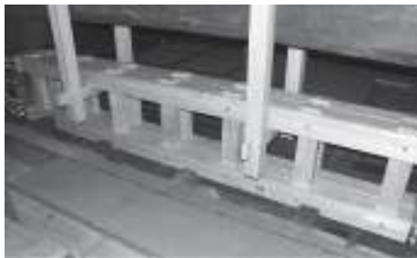
天井裏に「はしご型フレーム」梁を二重にして設置
