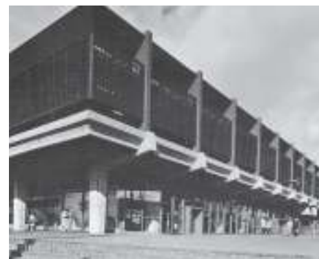
サンボールホール（上）現況（下）竣工時*
