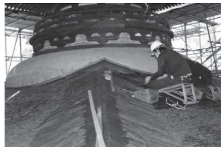
檜皮葺きの修理 石山寺多宝塔
