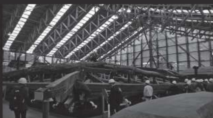
2015 仁和寺観音堂 修理工事
