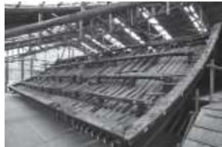
東寺東大門の解体修理状況
