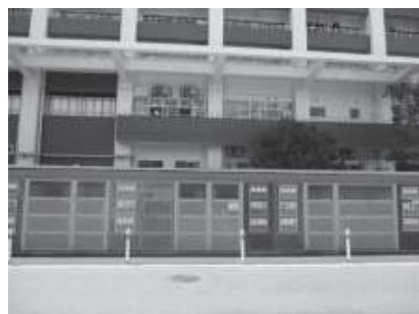
改修されたゴミステーション
