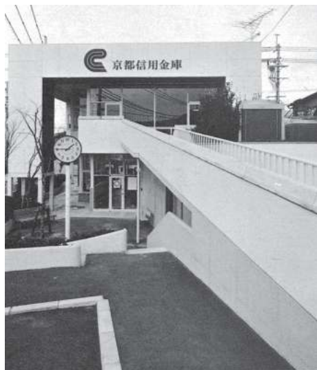
京都信用金庫東亀岡支店 ＝「建築と社会」1980年3月号
