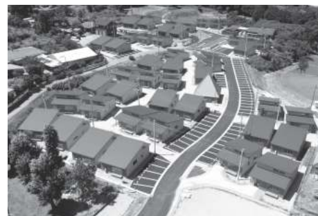
みんなの家を中央に配した災害公営住宅団地 (西原村山西地区)
