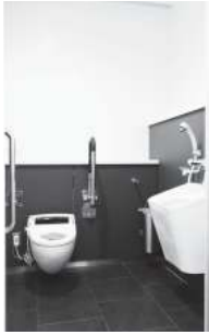
写真3 一般トイレ内に配置されたオストメイトトイレブース (羽田空港国際線ターミナル)
