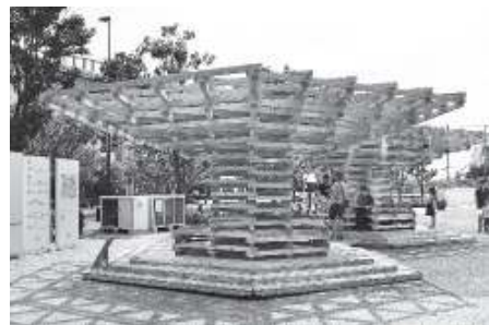
柏の葉に設置したCOOL TREE
