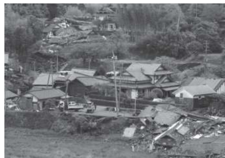
大切畑集落の被災状況
