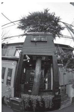
「Bar Escape」外観
