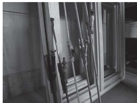
写真3 窓の部材は廃棄せずに保管し、活用する
