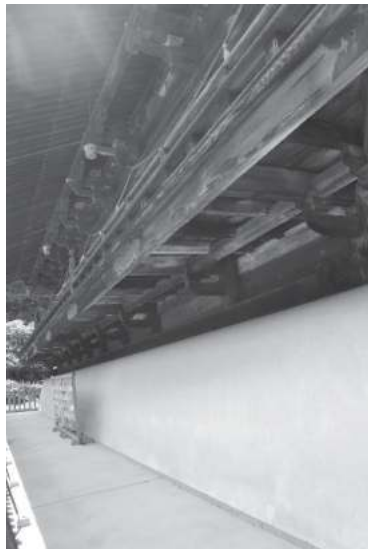
⑪吉備津神社本殿の基壇・縁組
