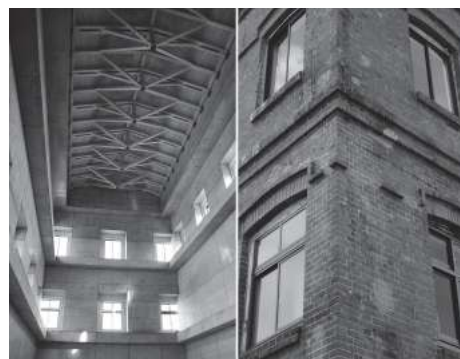
写真2 木トラスによる赤レンガ建築の再生
