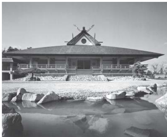
②竣工時の大教殿正面
