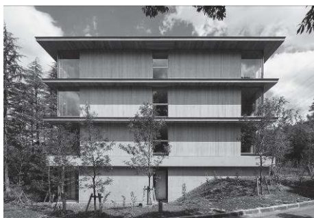
写真5 床パネルをはね出し、四周に底を設けた外観
