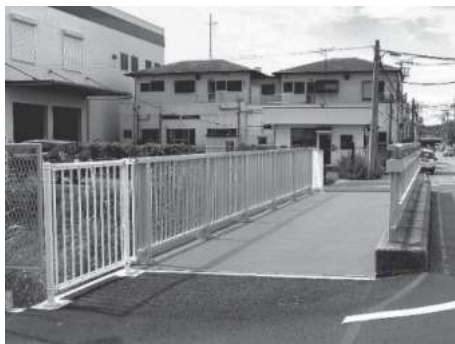
写真6 「半助橋（神奈川県）」当協会会員会社撮影（幅員2.7m・長さ11.4m、橋台ブラケットに床版を締結）
