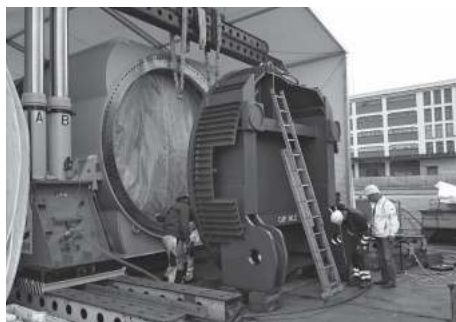
写真2 輸送用アタッチメント取り付け作業
