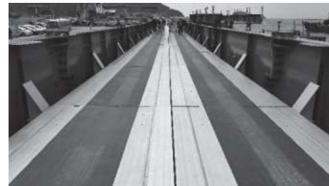
写真2 「緊急仮設橋」当協会撮影（橋長60mを7ブロックに分割して保管・運搬）
