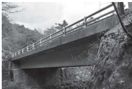
写真1 「金慶橋」当協会撮影（竣工後57年経過しても良好な表面状態を維持している）
