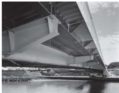
写真4 「すさみ大橋（和歌山県）」当協会会員会社撮影（主桁側面より鋼製ブラケットを持ち出し、その上にアルミニウム合金製床版を設置）
