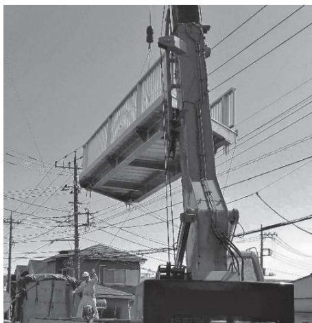
写真5 「コンパクトブリッジ吊上げ施工状況」当協会会員会社撮影（クレーンで吊り上げブラケットに設置、即日通行可能）
