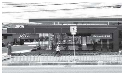
写真1 15mキャンチレバー屋根
