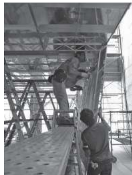
写真4 内部のアルミニウム製トラス
