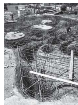
写真7 レストランノエルの掘削+配筋風景 (建設中, 建築家: 石上純也)
