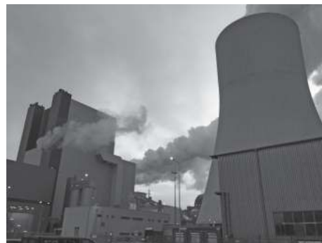
写真1 Kozienice火力発電所完成写真
