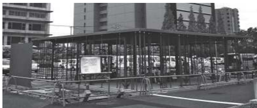
写真1 東京ガス千住見学サイト Ei-WALK（建築家：伊東豊雄）の鉄骨建方状況
