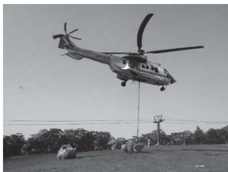
写真4 ヘリコプターによる重機輸送状況
