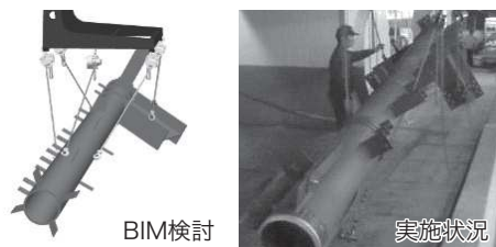
写真1 鉄骨輸送BIM検討と実施
