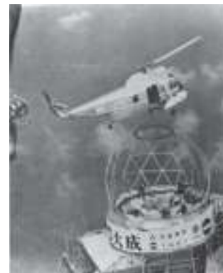
写真1 富士山頂レーダードーム 据え付け作業
