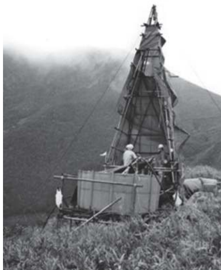
写真1 山地でのボーリング調査
