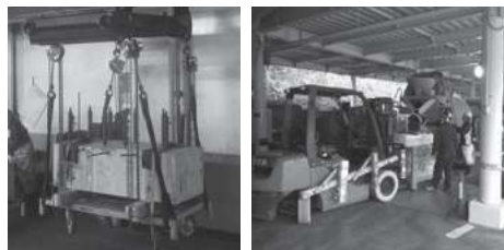
写真2 基礎PC・生コン輸送状況
