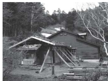
徳本峠小屋外観（左手前が休憩棟、その奥が宿舎棟、さらに奥がトイレ棟）
