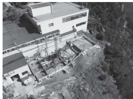
写真5 小型ジブクレーンを使用した鉄骨建方状況
