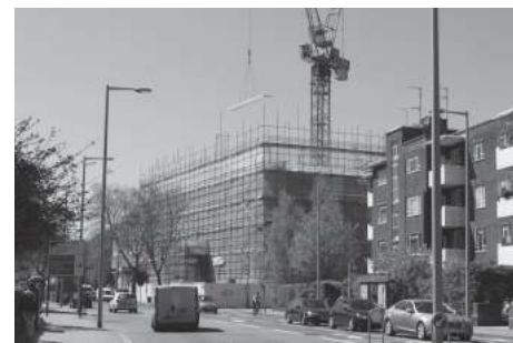
写真3 Kingsgate House施工中外観 筆者撮影
