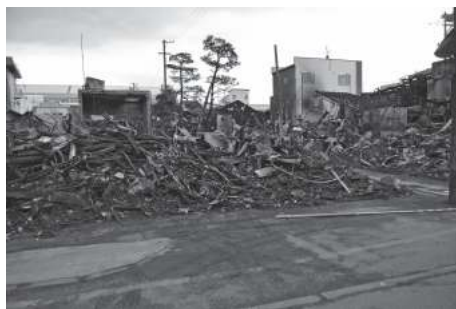
写真1 糸魚川大火の出火家屋風下の市街地の様子（中央右は燃え残った準耐火建築物）
