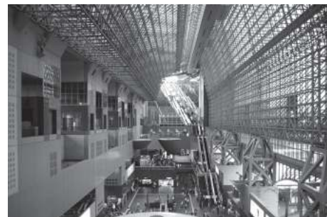
写真1 JR京都駅ビル
