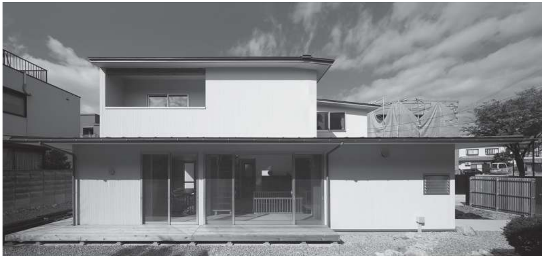
南側から見る外観
