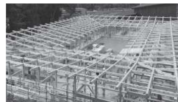
架構建て方状況
