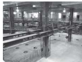
写真3 集中切梁を用いた大開口計画
