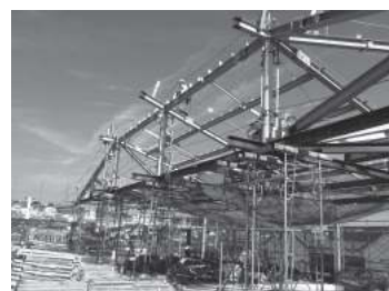
写3 3Dトラス屋根の鉄骨建方状況
