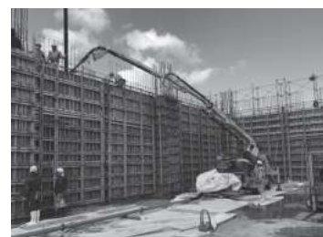
コンクリート打設状況
