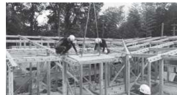
CLT落とし込み状況
