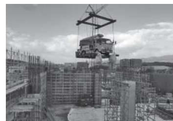
2tポンプ揚重状況
