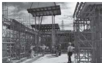
型枠支保工のユニット化(1)
