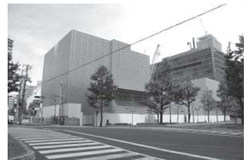
南御堂 本堂は変わらないが、御堂筋に面した会館は建替えられ、超高層ホテルが建設される（現在工事中）。
