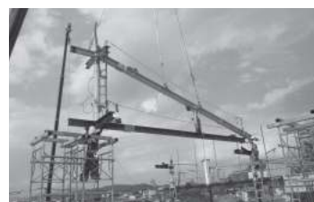
写2 3Dトラス屋根の地組ユニット
