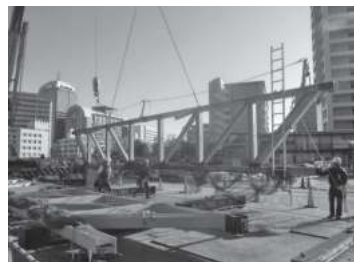
写真1 トラス鉄骨 地組み立て起こし状況
