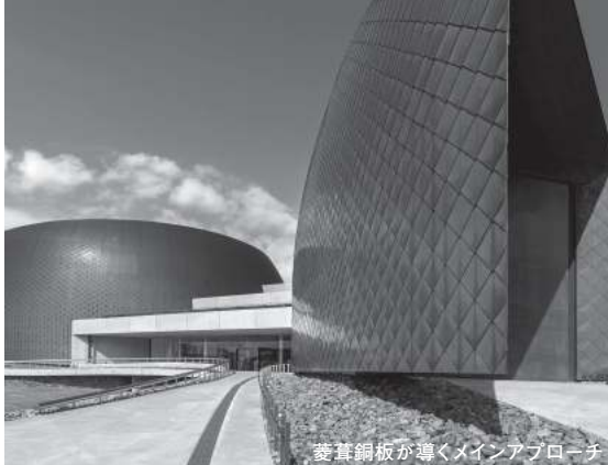
菱葺銅板が導くメインアプローチ
