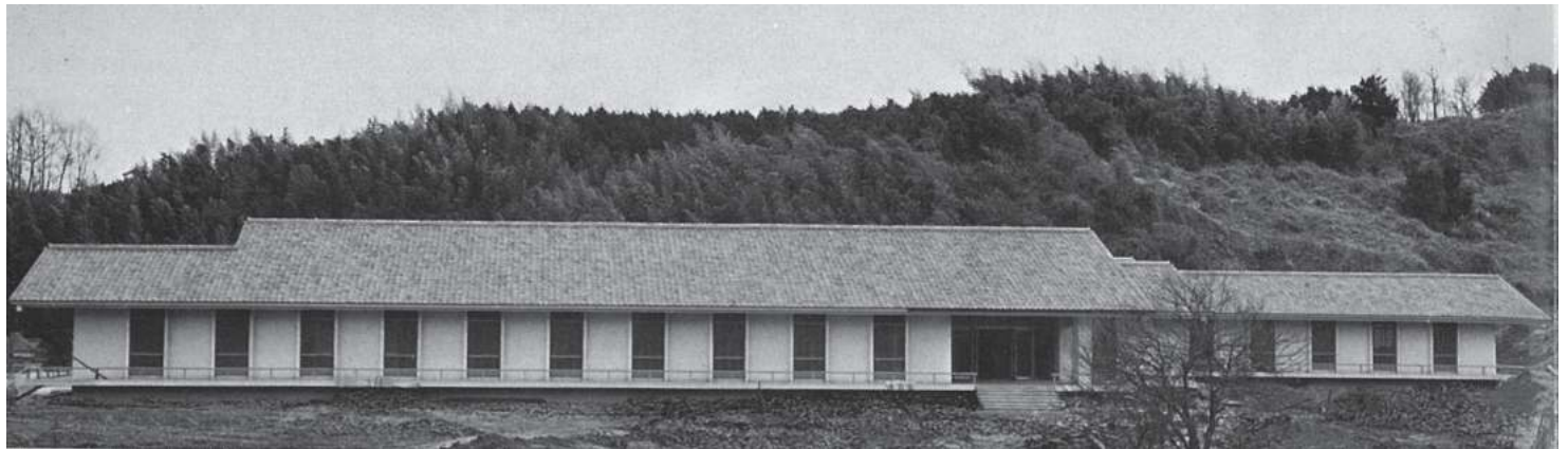
⑩竣工した飛鳥資料館（南から見る）
