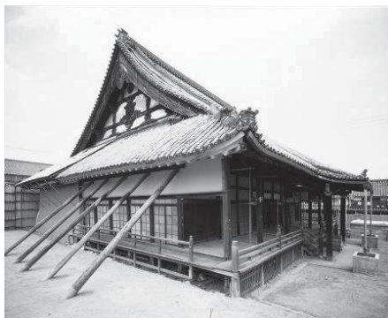
本堂外観 (修理前 南東より)
