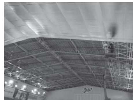
図3 シーリング設置状況
