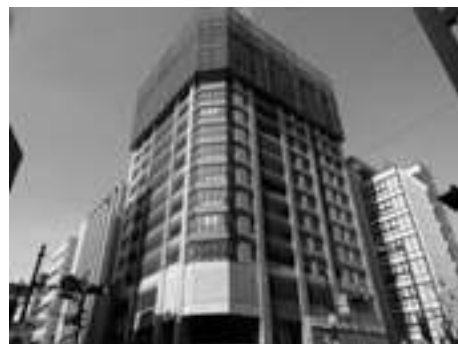
写真1 現在施工中のクレヴィアタワー大阪本町新築工事。超高層であり安全に非常に気を遣う現場である
