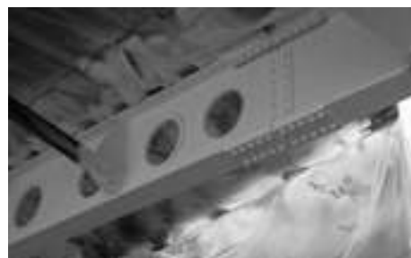
写真2 筆者が手掛けた新開発の耐火被覆材
