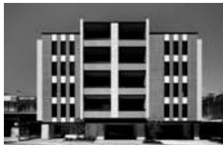
写真3 前回施工のジョグランデ岡本一丁目新築工事。宮水等、特に地下工事に苦勞した物件である。
