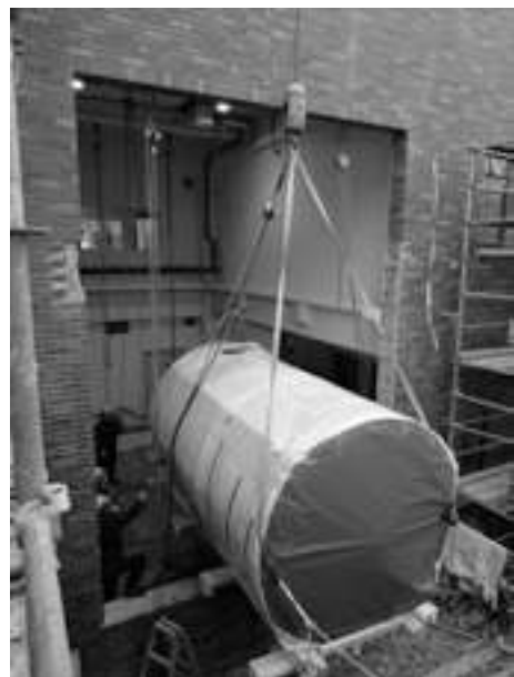
写真1 外壁を解体しタンクの搬入
