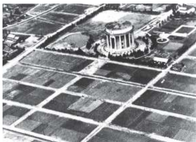
竣工当時の配水塔と水道公園 (名古屋市上下水道局提供)
