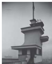
船橋状塔屋（再生前）
