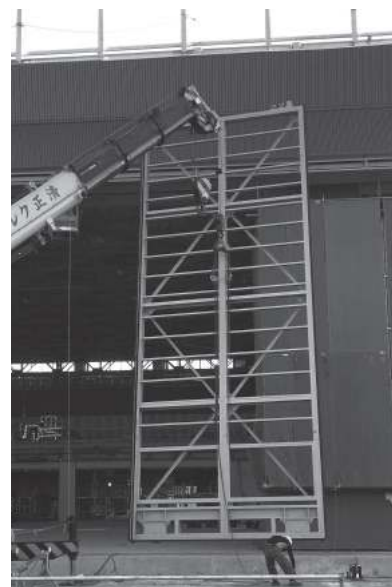
扉の建て込み作業
