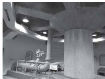
水槽下の4階に残るバルブ(筆者撮影)
