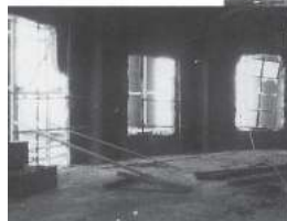
窓の断(はつ)り
