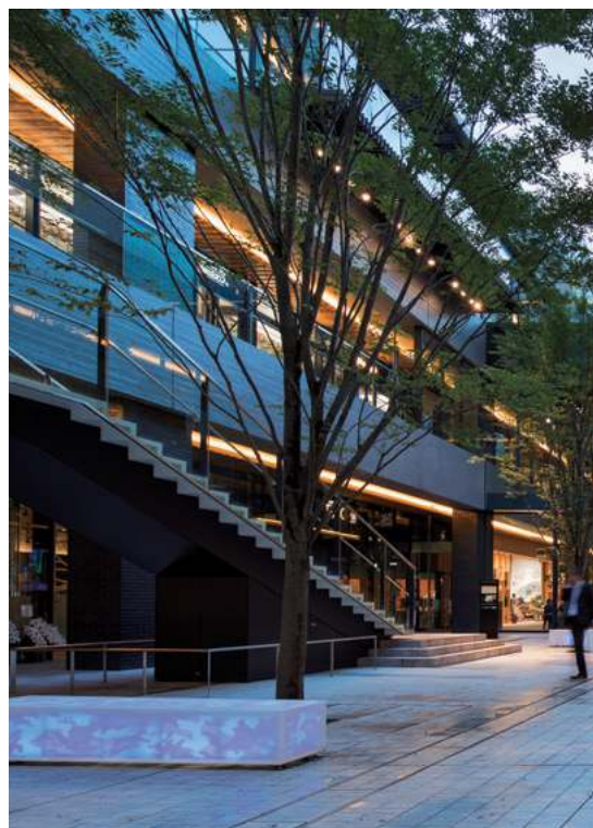
屋上庭園からオープンエアプラザを見下ろす。商業の賑わいが屋上庭園まで立体的に連続する
