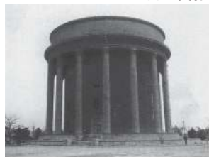
改修工事直前の 旧稲葉地配水塔 (昭和40年)
