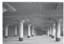
フラットスラブ（再生前）
