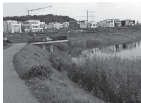
写真7 フェニックスジー（ドルトムント）
