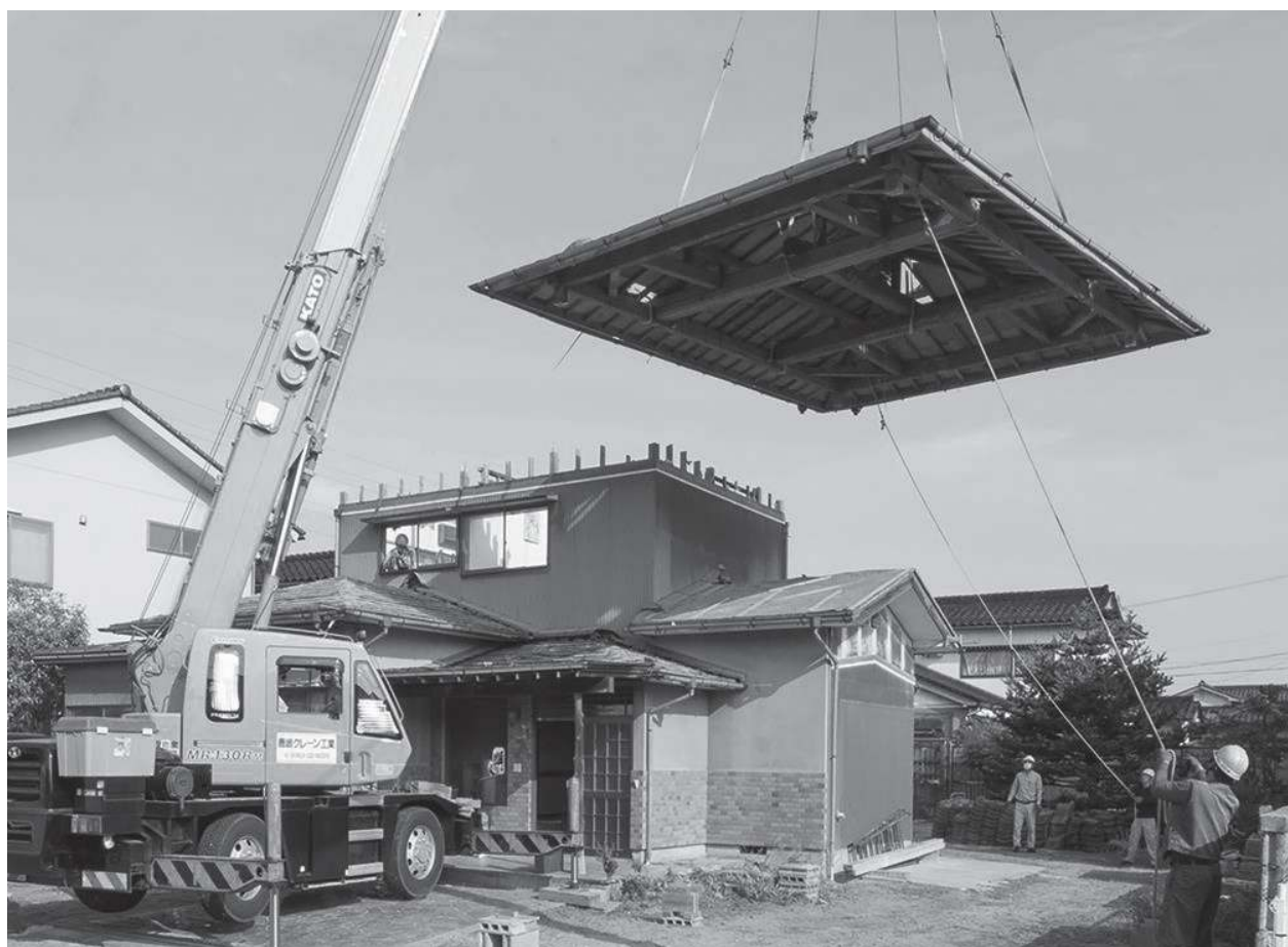
写真4 クレーンでの既存屋根の移設の様子
