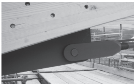
写真3 集成材と鋼材の接合部
