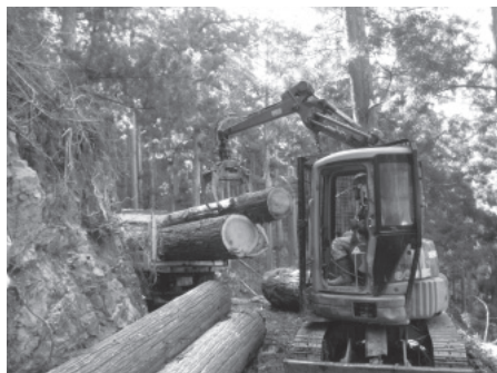
写真2 危険な急傾斜地を安全な平坦地に変える
