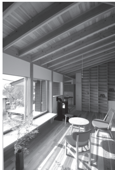
写真6 Jパネルを用いた木造住宅。構造材は和歌山県産のスギ材。冬の日差しがたっぷり入る暖かい木の空間になっている
