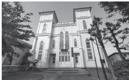
写真3 日本基督教団弘前教会（青森県） キシラデコールコンゾラン ライトアイボリー塗装
