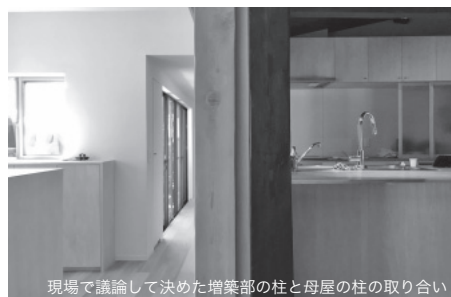
現場で議論して決めた増築部の柱と母屋の柱の取り合い
