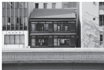
写真2 北浜長屋（土佐堀川面）撮影：高岡伸一
