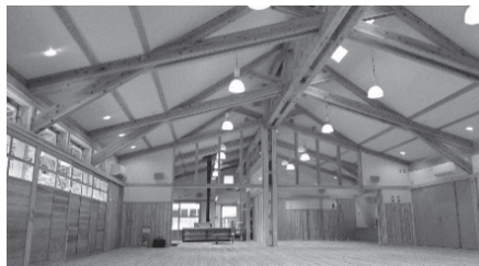
写真4 綾部市里山交流研修センター「森もりホール」
