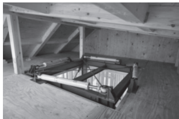
写真13 ダンパー設置状況
