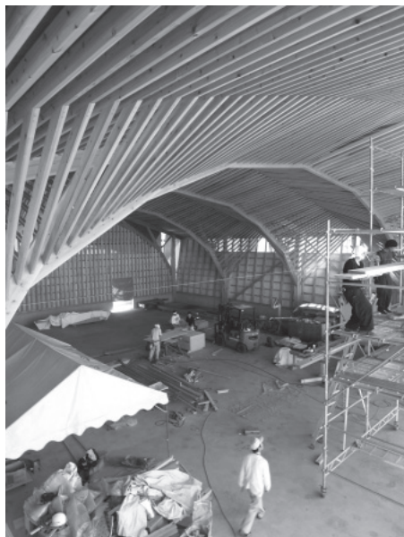
写真3 地域に根差す大工工務店が手刻みで造った。若手大工たちも自信を持ったという
