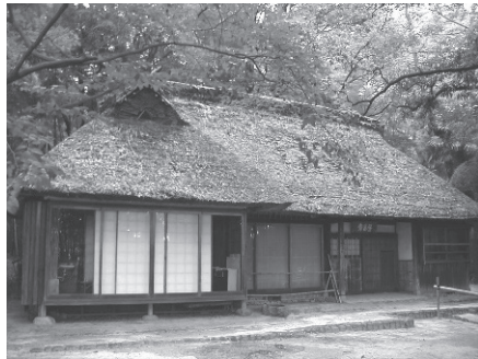
写真1 築約90年の民家
