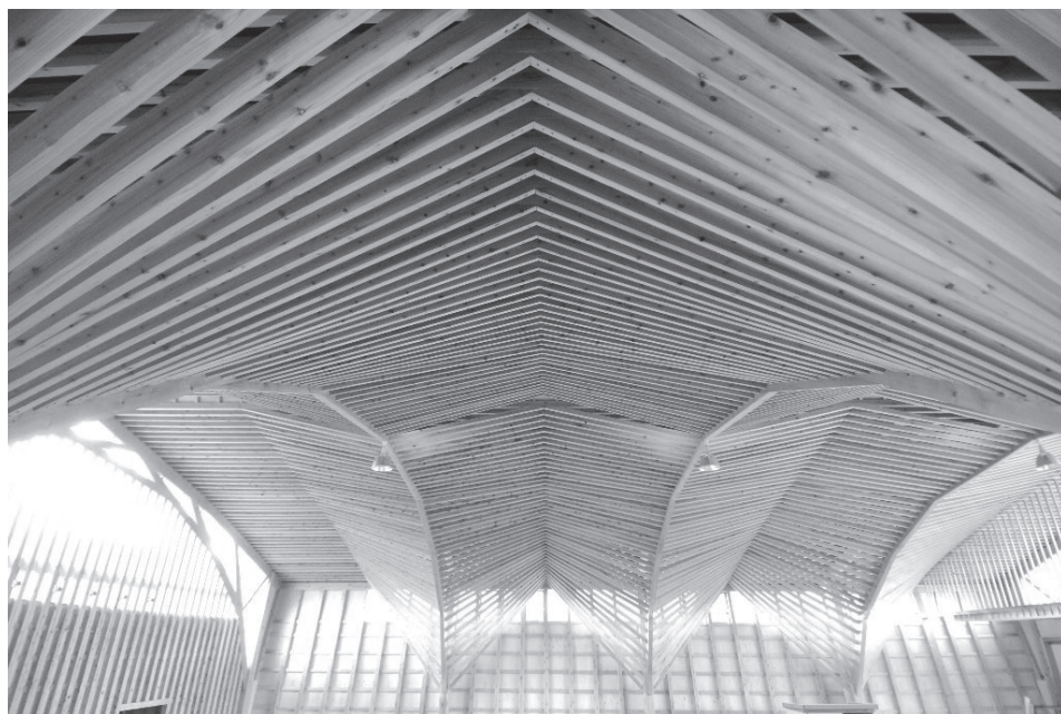
写真4 北沢建築工場。住宅に使われる一般的な部材で構成されている。最大断面は360mm×120mm。母屋材、ほおづえ材は105mm×55mm
