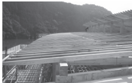
写真1 垂木掛けが完了した小学校校舎
