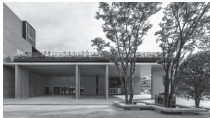
写真2 RC打ち放し天井とRM壁柱で魅せるエントランス
