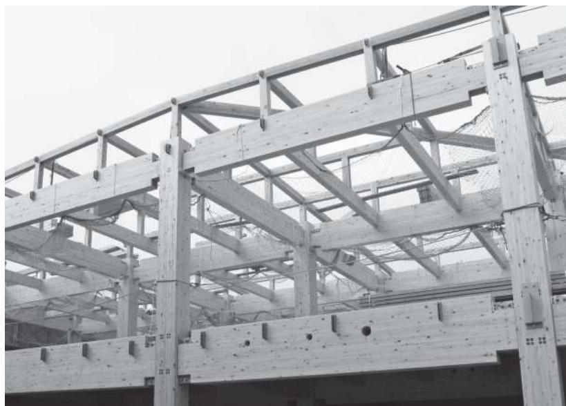
建て方中の木構造。すべて地域産材（真庭産材）を使用
