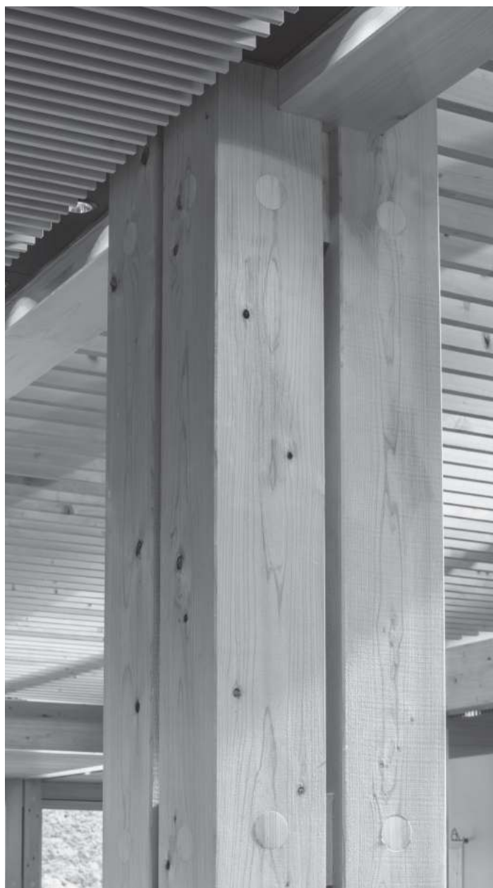
210mm角の地域産の一般製材を4本束ねたディテール これにより、構造体での地産地消が実現 汎用性の高い工法とすることで、今後の広い普及を目指している
