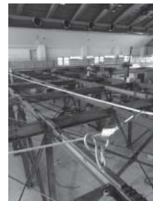
小型重機による鉄骨建方
