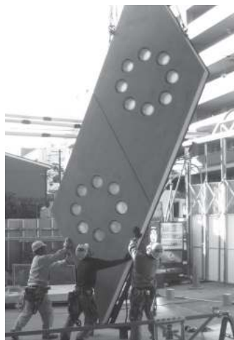
GRCパネル施工状況
