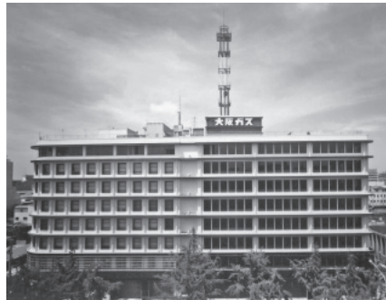
写真1 大阪ガスビル南北両館（御堂筋側から）
