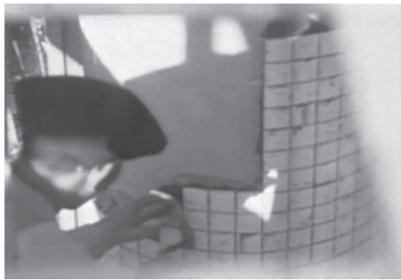
写真3 タイル手貼り（記録映画より）
