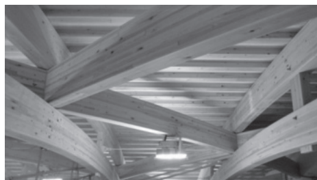
写真2 施工中の様子（内観）
