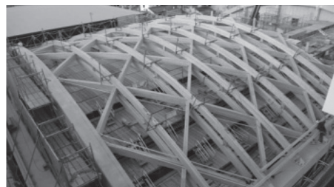
写真1 施工中の様子（外観）
