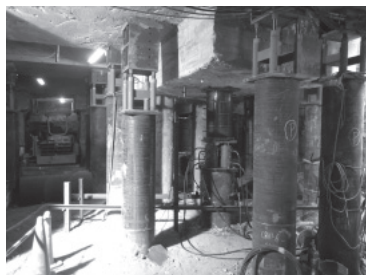
写真2 ベダスタル杭(中央奥)と鋼管杭(本設杭圧入時)
