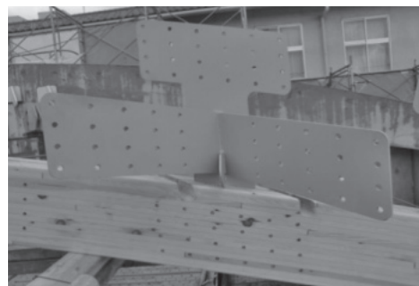
写真3 上下弦材、斜材と接合金物
