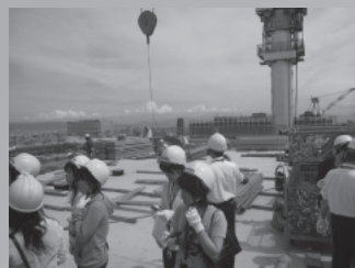
2012/7/19 大阪駅北ヤードBブロック
