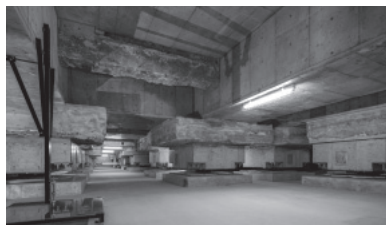
写真3 完成した免震層(大正時代の基礎と免震装置)
