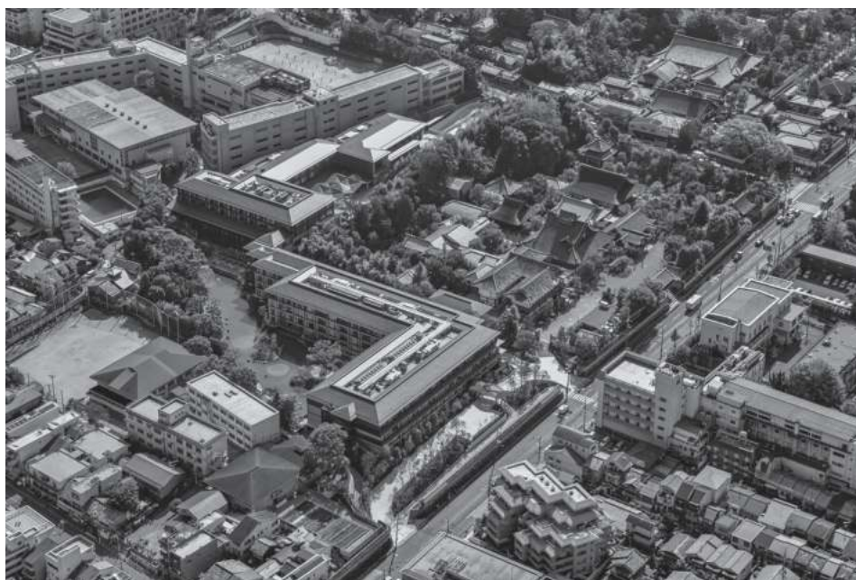
写真2 全景の航空写真
