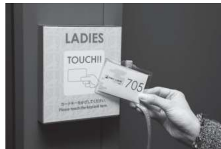
写真1 キャビンエリアにはセキュリティカードをかざして入館する
