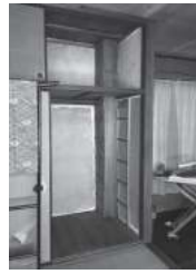
図3 押し入れに隠された通気筒（木製ダクト）
