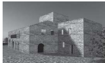
写真2 保存するファサードの壁のバース
