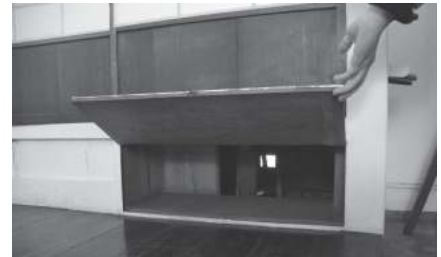
図5 小上がりとの段差に設えられた調理室の通気口
