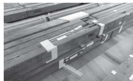
写真3 既存木材の補修状況
