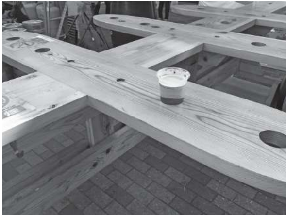
天板の穴には角座広場の屋台で販売されている飲み物のカップがおさまる。
