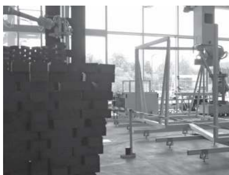
ETHにおけるロボティクスによる施工
