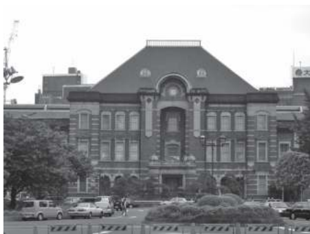
図1 東京中央停車場(東京駅、1914年。写真は2006年撮影のもの)。煉瓦が前面に出た鉄骨煉瓦造の代表的な建物
