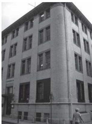
図2 三井物産横浜支店1号館(現物産ビル、1911年)。RC造の壁の上に磁器タイルが貼られている
