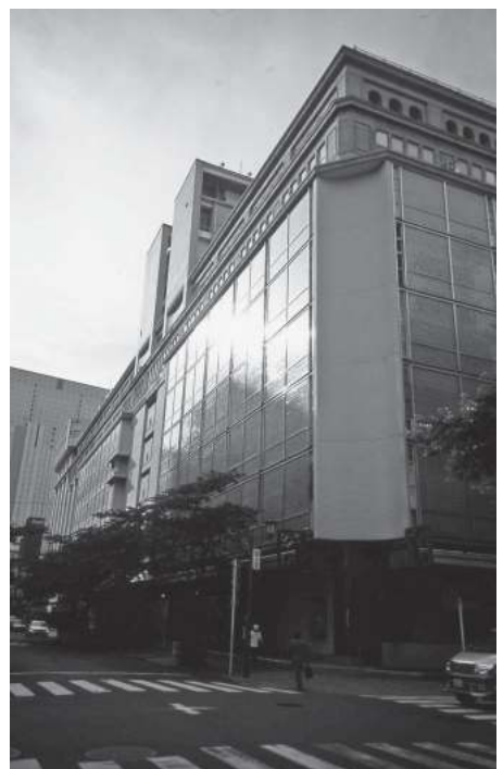
写真2 村野藤吾による増築部分外観の現況
