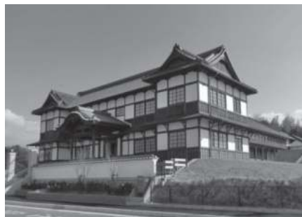
写真1 免震改修後の建物外観
