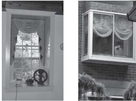
写真7 左は窓の内側、右は窓の外観
