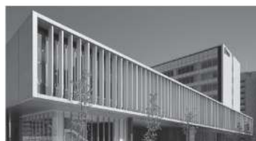
西日対策の縦ルーバー
