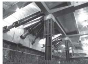
写真5 斜梁・RCバットレス
