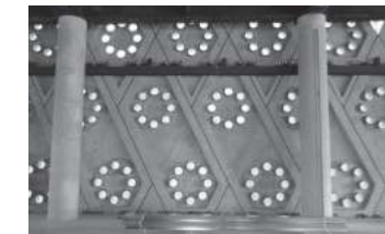
写真1 施工中のパネル裏側
