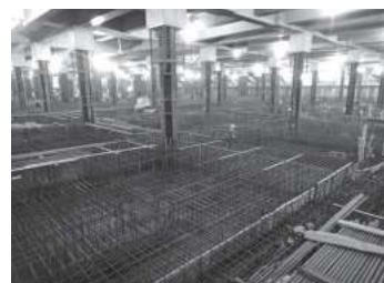
写真6 地下躯体工事状況
