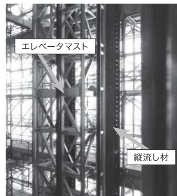
写真1 縦流し材設置状況
