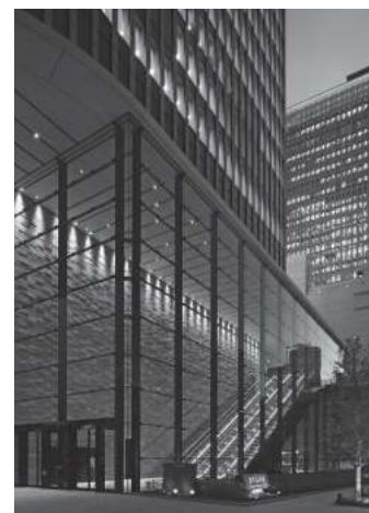
低層部北側外観
