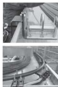
写真1. 延線治具と配置状況
