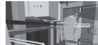
【誘引通風機室内プラント機器と有圧扇の干渉確認】
