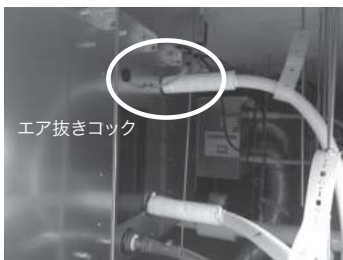
写真1 FCFUエア抜きコック
