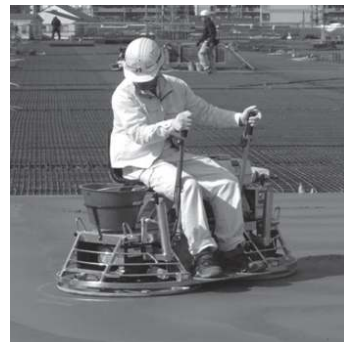
写真4 小型騎乗式トロウエル使用状況
