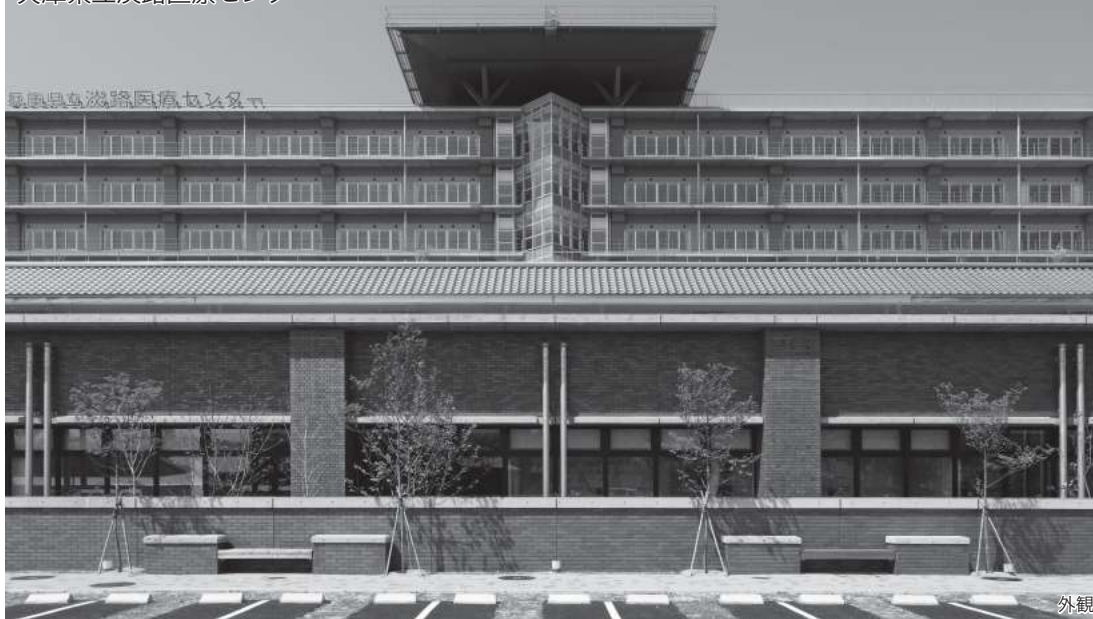
兵庫県立淡路医療センター
