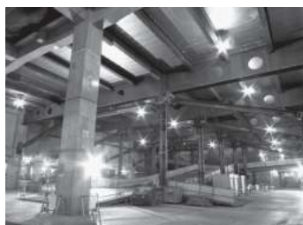
写真3 仮設スロープ設置状況
