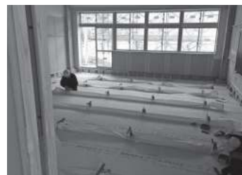
図-5 床放射空調用ダクト施工写真
