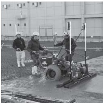
写真3 ミニスクリード使用状況
