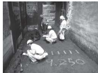
写真2 注入実験（掘出し調査）
