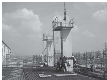
図2 柱躯体のプレキャスト化
