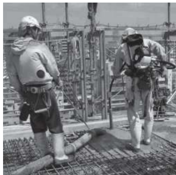
写真2 バックパック式エンジンパイプレータ使用状況
