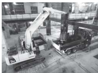
写真4 5次掘削状況（B2階）
