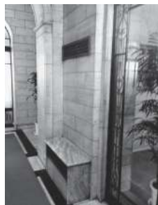
写真4 (※) 玄関ホール 壁面に吹き出し口 ベンチ下部に吸込み口
