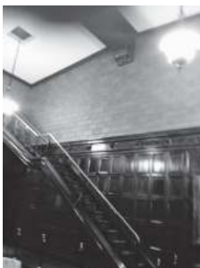
写真5 (※) 談話室コード ペンダント吊元及び 木製壁面一部に吹き出し口 ※筆者撮影
