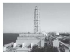
泉北天然ガス発電所
