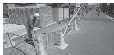
非開削工法によるポリエチレン管の埋設
