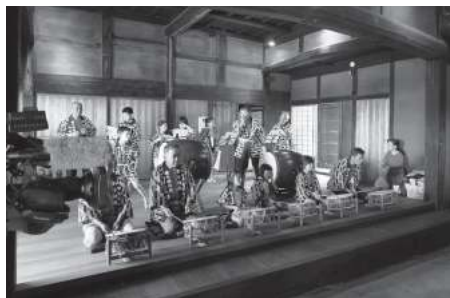
旧市川家住宅内観 土間廻り（整備後）
