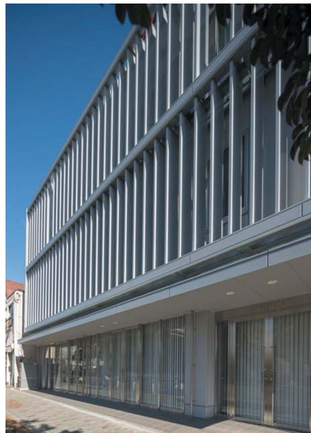
セットバックした空間を利用した日除ルーバー
