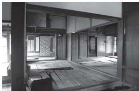
旧市川家住宅内観 土間廻り（修理後）
