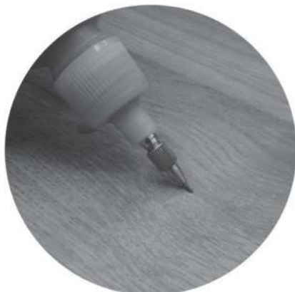
継ぎ目にノズルを差し込んで専用液を注入
