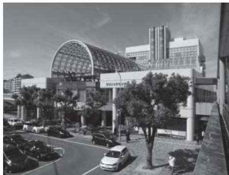
ニュータウンの玄関口である西神センタービル
