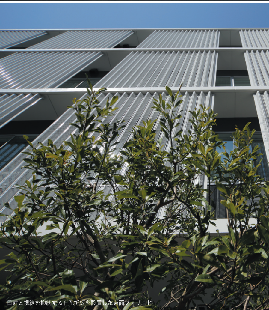
杭頭免震装置を設置した12本のコンクリート柱が執務空間を支えるシンプルなデザインの正面外観
