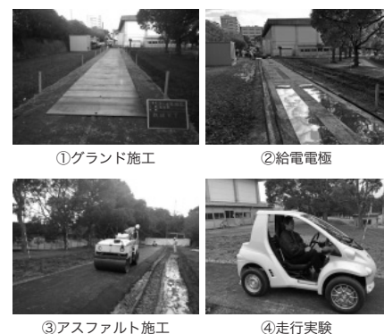
図4 豊橋技大に施工した電化道路
