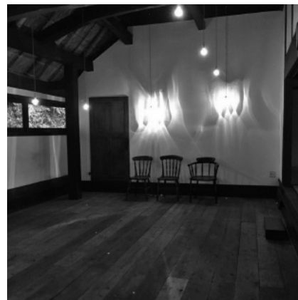
客席床 湿気で腐っていたものを防湿RCの上にかけて直す
