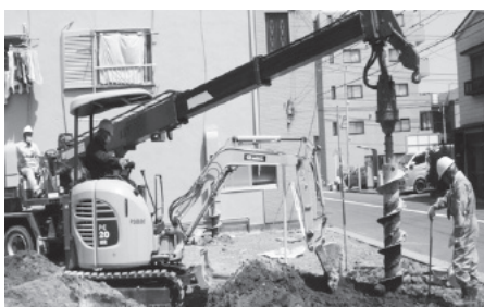
写真-4 狭い住宅地での施工の様子
