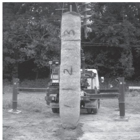
写真-2 均一で不純物のない連続したコラム
