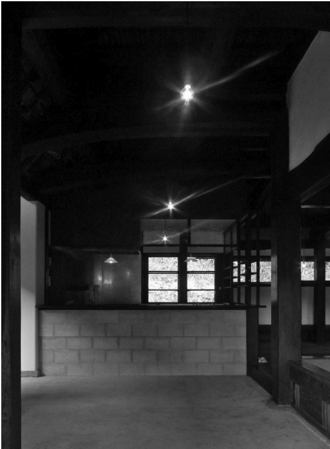
母屋 客席の土間 奥は厨房 前の改修により塞がれていた壁や障害物を除き、光と風をとりもどす
