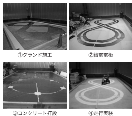
図3 建物フロアの施工
