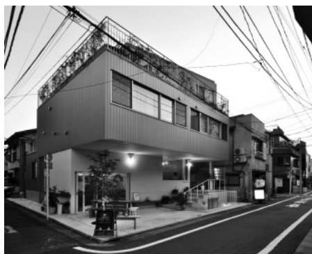
写真1 外観（仲建築設計スタジオ撮影）
