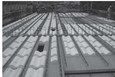
写真1 サイレントボイドの現場設置状況
