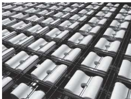
写真2 打ち込みサイレントボイドの設置状況
