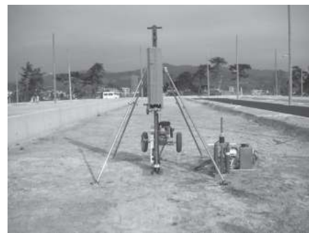
写真1 試験機の全体状況
