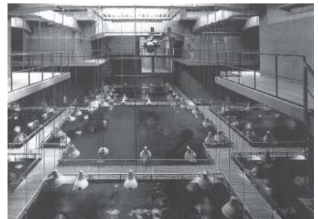
写真7 海遊館スラブ上部の波返しスラブ
