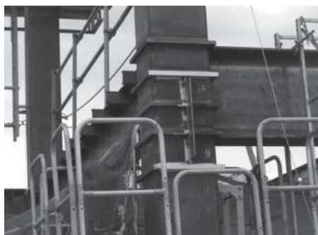
写真2 ダイアフラム5段の複雑な柱梁接合部
