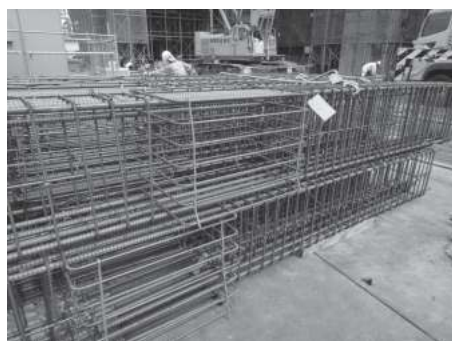
写真9 作業所の空きスペースでの組立鉄筋
