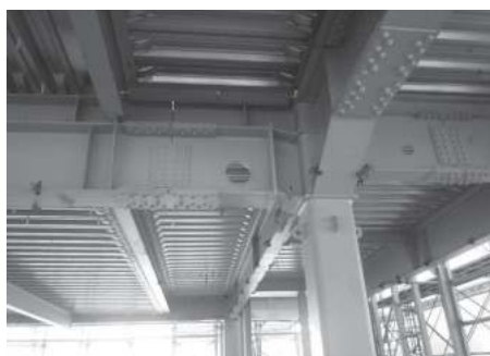
写真3 ハンチやT形鋼による複雑な大梁端部
