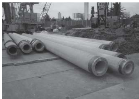
写真1 PC杭が並んだ作業所
