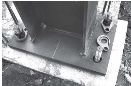
写真1 大地震にも強いベースバック柱脚工法
