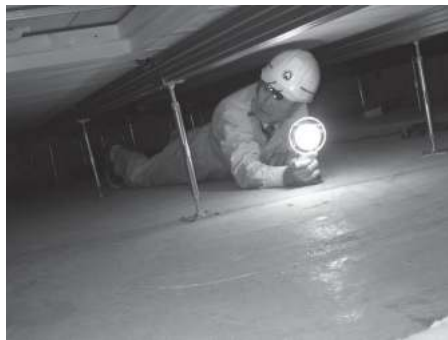
図1 床下点検作業
