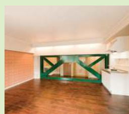
ブレース補強をした室内／伝法
