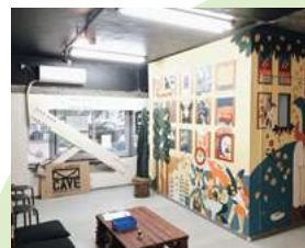
鉄骨のブレース補強／森之宮
