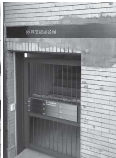
無数のアンカーボルト跡や左官補修跡をそのまま残すエントランス
