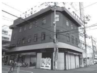
リノベーション前のサイディングで覆われた外観
