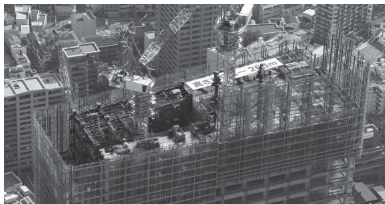
写真3 スライド養生枠に囲われた中での鉄骨建方状況
