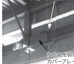
図5 外装部断面図とPCa版下地鉄骨
