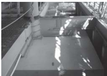
図4 鉄骨基礎梁と基礎の納まり
