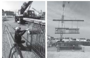
図4 地組スリーブ取付け状況
