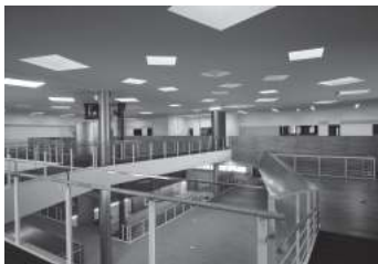
図2 オープンエリア吹抜部
