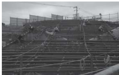
3次元屋根の鉄骨の施工（きらりタウン支店）
