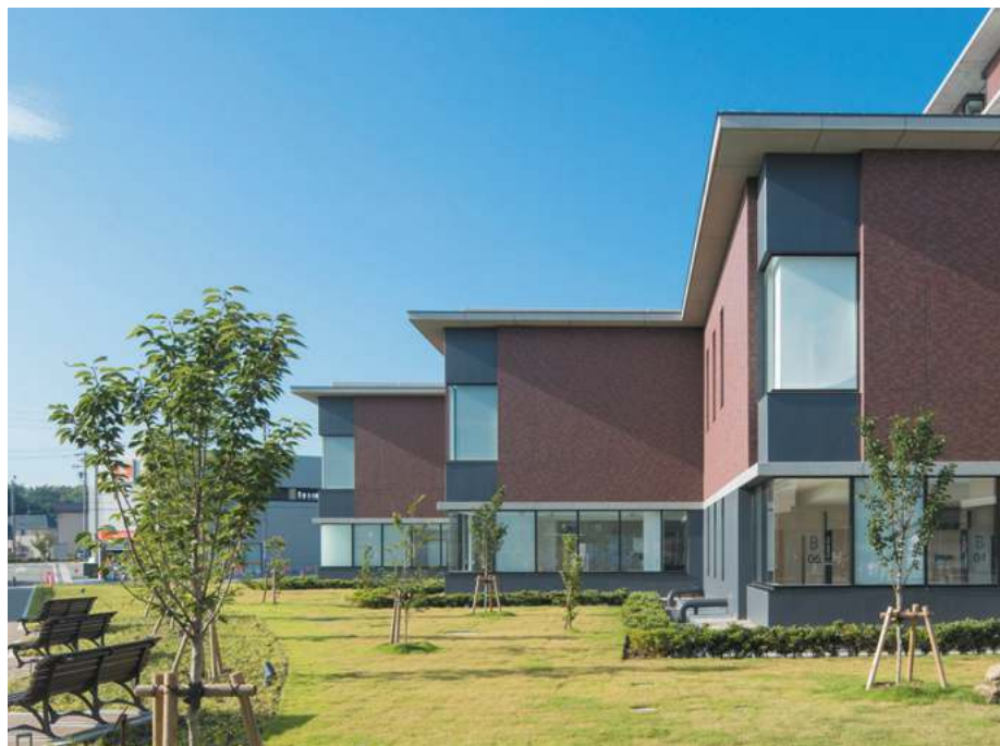
東側の雁行する外観 外来側の緑と街をつなぐ遊歩道
