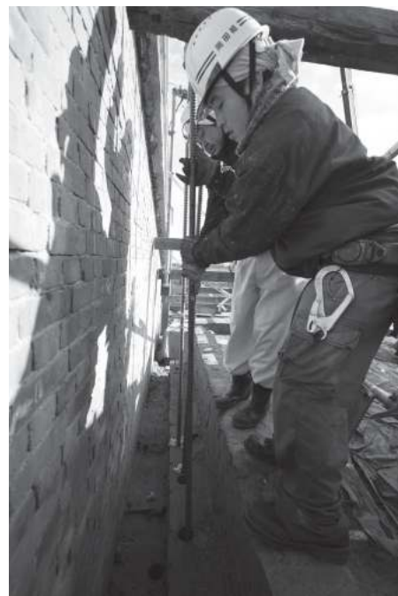
鉄筋挿入工法
