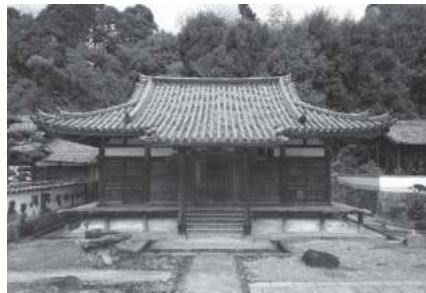
写真1 修理前の長福寺本堂
