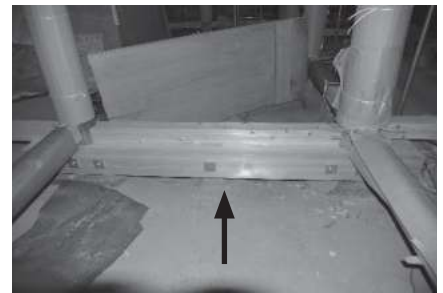
写真3 柱の足元を木材で挟み込んでボルト締めした構造補強
