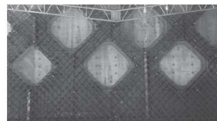
写真2 壁の配筋状況
