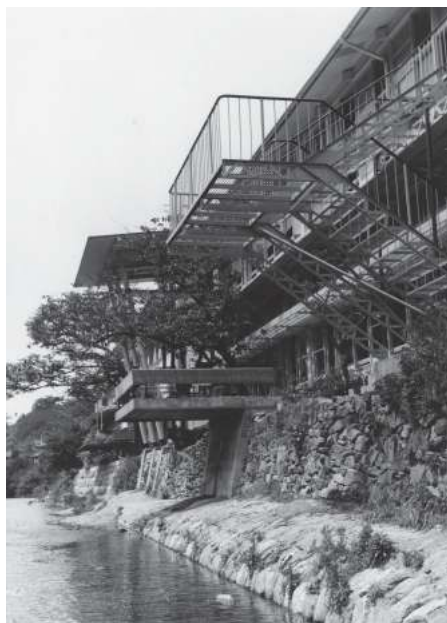
写真2 竣工直後の日土小学校。川側外観 (日本建築学会蔵)
