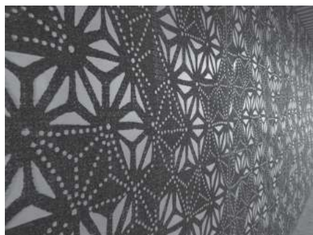
船場センタービル 御堂筋側 設置
