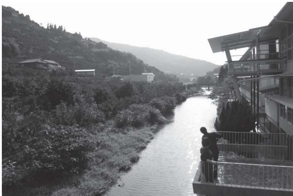
写真6 日土小学校の川側の光景。校舎が建ったことで周囲の環境の中に新たな関係が生まれている
