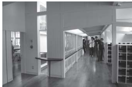
写真5 日土小学校・東校舎の昇降口。柱・梁とも丸面取りされているためにその間の壁が少し後退し、大壁と真壁の間の状態になり、「面」の構成が弱くなる
