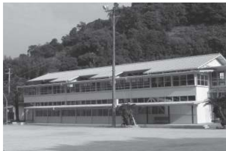
写真4 日土小学校・東校舎の外観。切妻屋根と水辺連続窓の組み合わせが独特の雰囲気を生み出している
