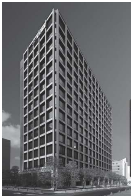
写真1 外観写真 鉄骨フレーム+花崗岩のファサード
