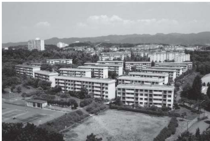
写真1 マンション建替前の光景（2001年）撮影：上田正人
