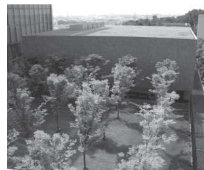
&lt;バラベット天端ギリギリまで植栽を施した例&gt;
