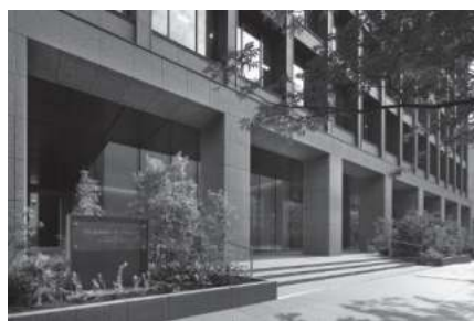
写真2 足元周り写真 基壇部 乾式石貼
