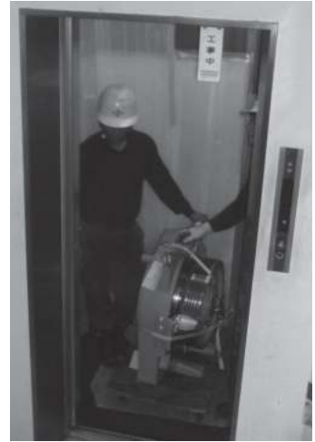
図2 既存エレベーターでの巻上機揚重
