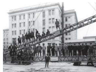
三井本館解体工事現場 技術者と職人が記念撮影 大正15年 三井文庫蔵
