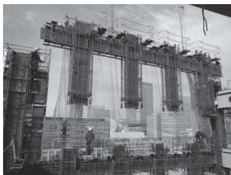
7節（12F梁、13F梁）地組鉄骨建方状況 壁面地組
