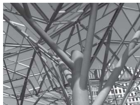
写真6 樹木柱見上げ
