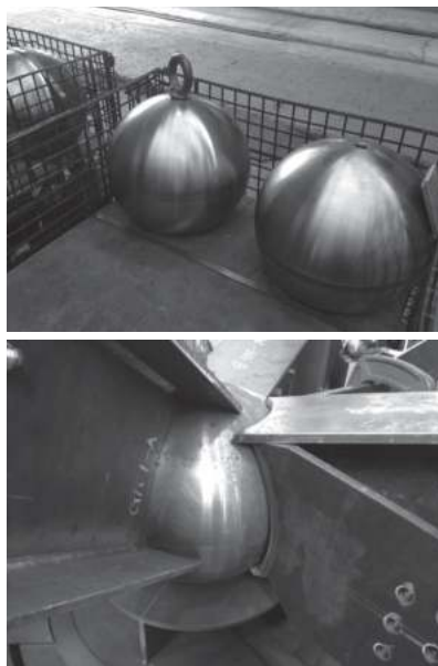
写真1 鍛鋼品ノードとノード接合部
