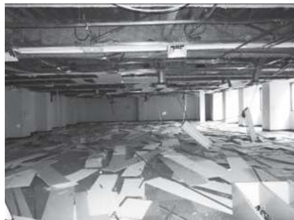
写真1 事務所の天井被害例
