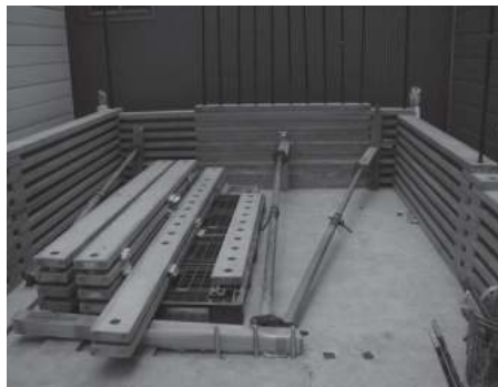
写真1 厚さ5cmの平板をすかし積みして建物を構成する
