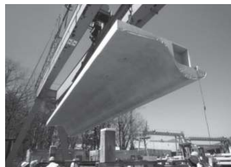
写真1 変形PCa梁の製作
