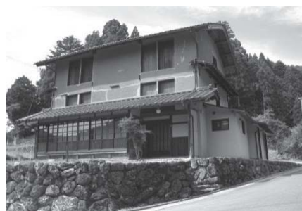
写真3 旧河邊邸（改修後）
