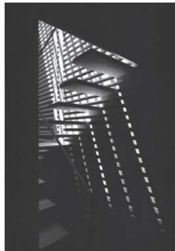
写真3 X階段見上げ
