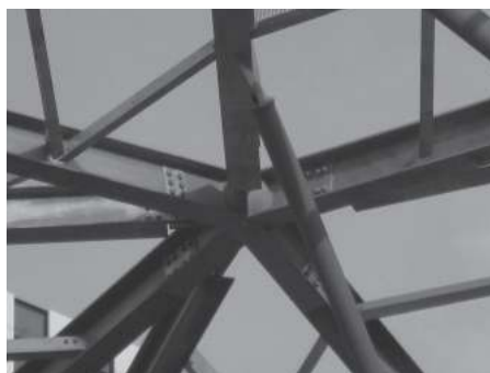
写真4 鍛鋼ノードを用いた接合部
