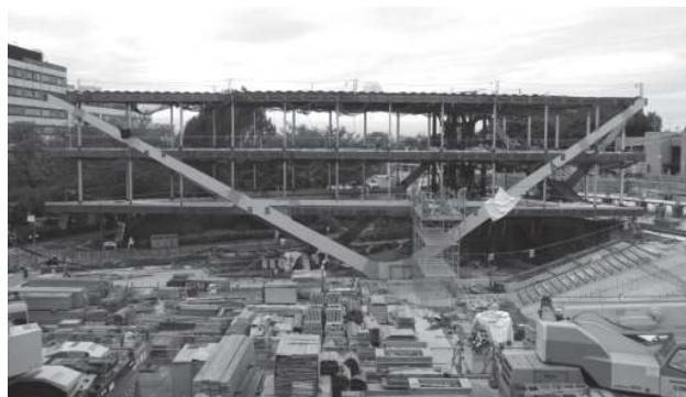
写真2 鉄骨建方完了時の学習棟
