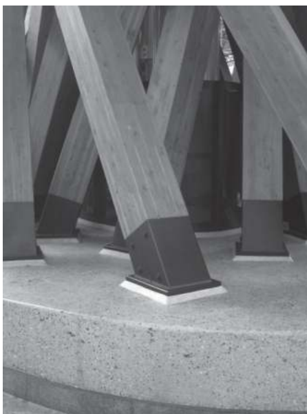
写真2 コンクリート板によって足元を固定
