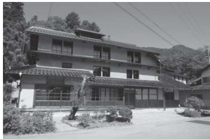
写真1 旧正垣邸（改修後）
