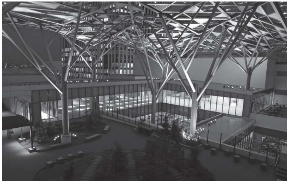
写真3 屋上庭園とこもれびルーフ
