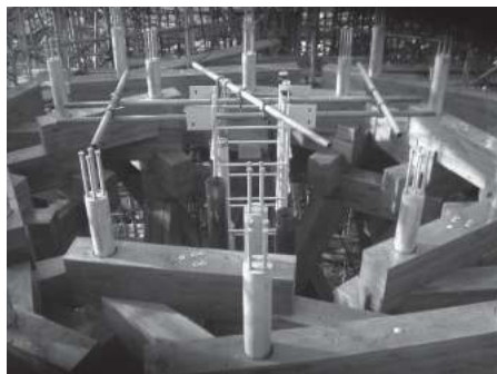
写真3 重ね梁接合部
