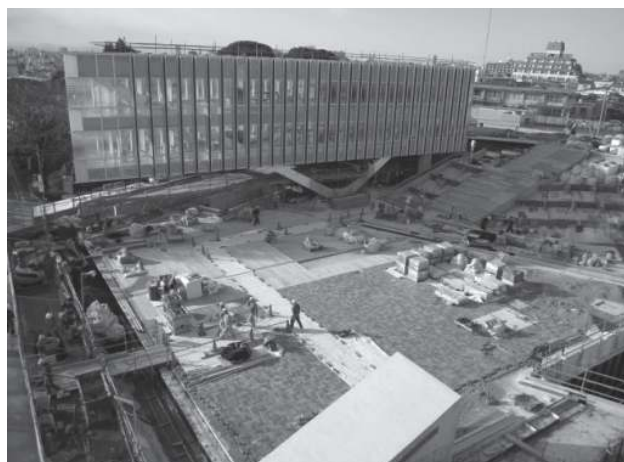
写真3 太陽光パネル付ルーバー取り付け時の敷地全景
