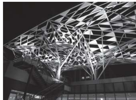
写真5 4階デッキからの見上げ
