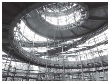
写真4 建て方中の螺旋階段
