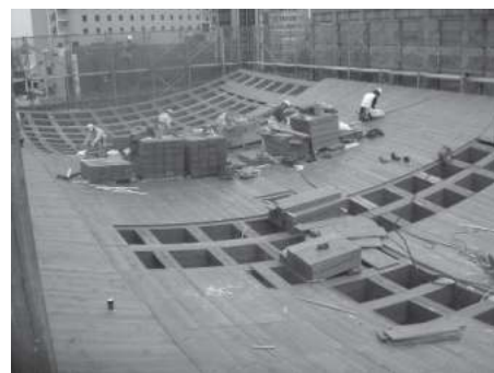
写真6 野地板施工
