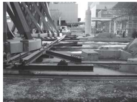
写真7 レール、構台設置状況
