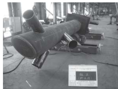
写真2 樹木柱の製作
