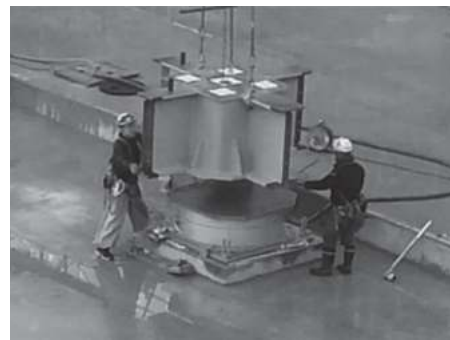
写真3 CFT・スマート免震柱脚の施工状況
