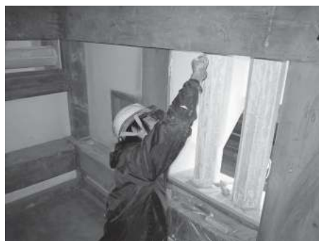
格子 漆喰仕上げ
