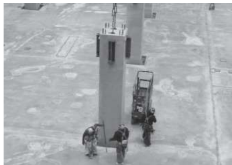
写真1 PCa柱の建方
