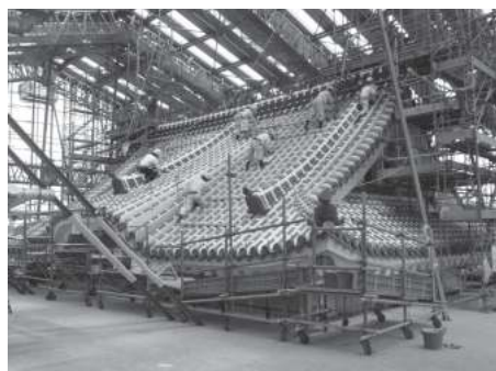
瓦目地漆喰仕上げ
