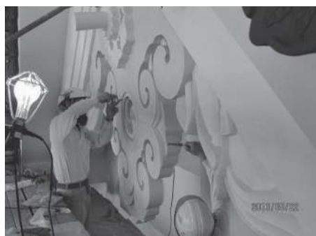
懸魚漆喰仕上げをグループで作業
