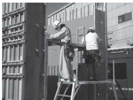
型枠コース実技訓練（型枠組立）
