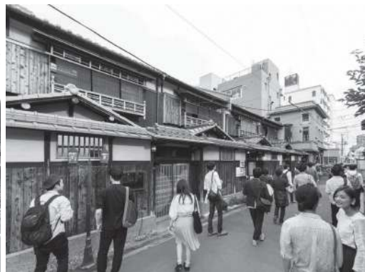
▲再生された寺西家長屋、現在は飲食店舗として活用されている
