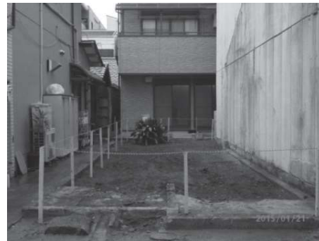
写真8 地上部分を解体、撤去
