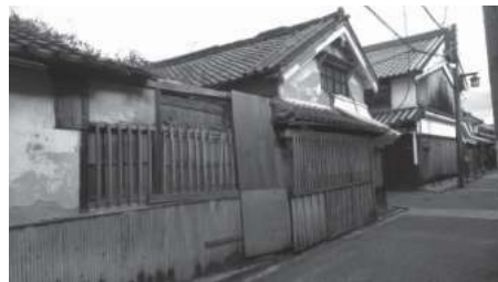
写真1 老朽化した空き町家
