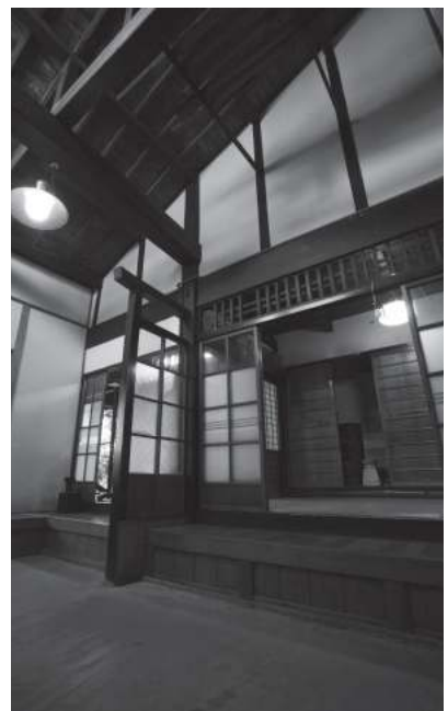
圧倒的な存在感を示す主屋の土間 (＊)
