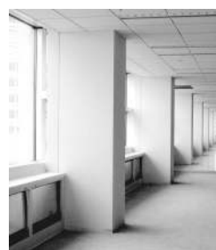
▲ 角柱の耐火被覆
