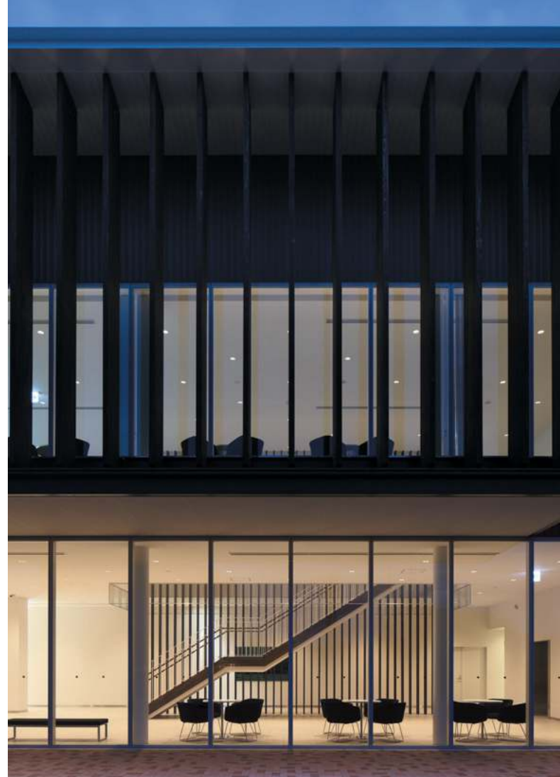
内部空間が表出するエントランスホール
