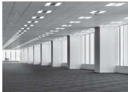
柱型耐火被覆（角柱）
