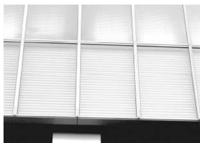
▲ カーテンウォールの耐火被覆
