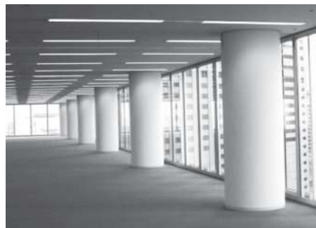
柱型耐火被覆（丸柱）
