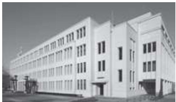
図-4 改修後の中高棟外観(南東側より)
