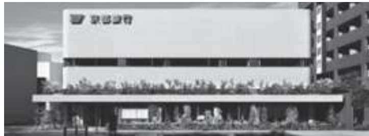
写真1 京都銀行歌島橋支店
