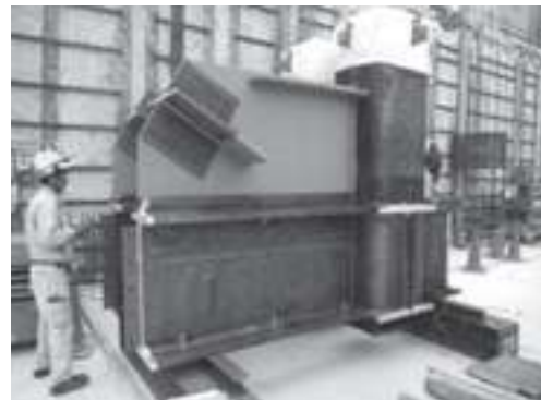
写真3 鉄骨ブレース接合部
