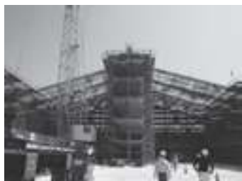
▲メインアリーナ屋根建方状況
