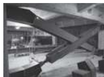
仮設ブレース
