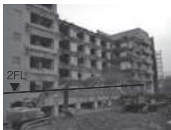
写真-2 地上躯体解体状況
