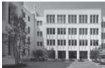
図-6 改修後の図書館棟外観(東側より)
