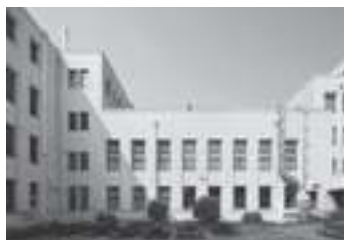
図-5 改修前の図書館棟外観(東側より)
