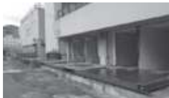
写真-1 作業構台架設状況
