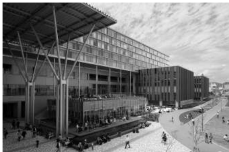
写真1 公園、街にひらいた「風のコンコース」
