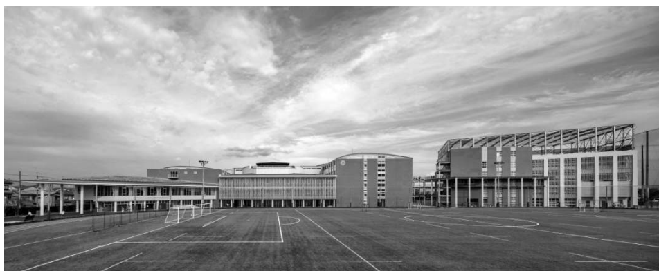
写真5 外観西面全景
