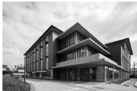
写真3 北西からの外観
